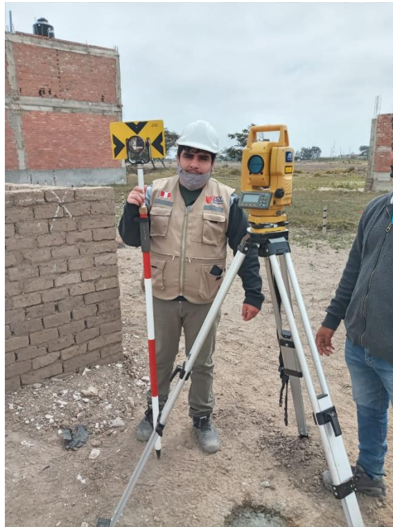
Foto 11. Estación total y Prisma.
