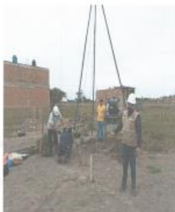
Foto N°09. Instalación e hincado de SPT-1.
