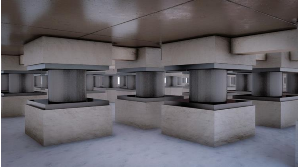
Vista 16. Vista de los aisladores sísmicos LRB en cimentación y del sistema estructural aporticado, Columnas, Vigas y losas aligeradas de la edificación de Vivienda Multifamiliar / Fuente: Elaboración Propia.
