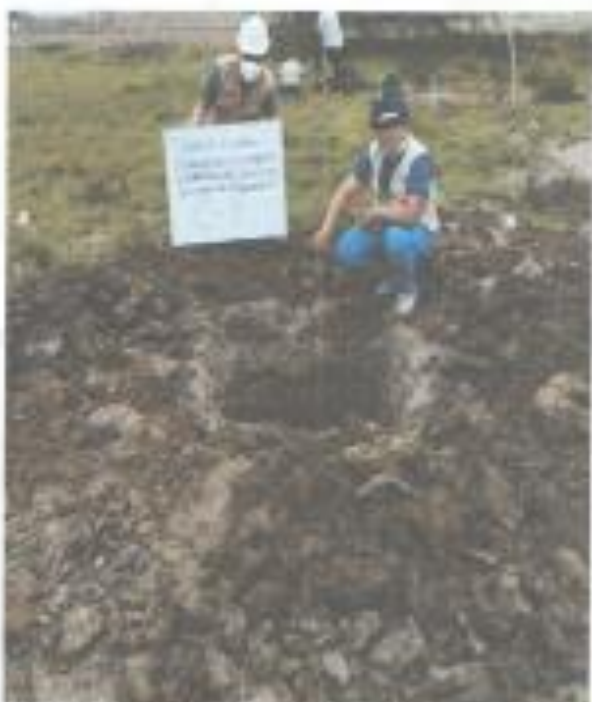
Foto N°06. Registro del perfil del suelo En calicata C-3.
