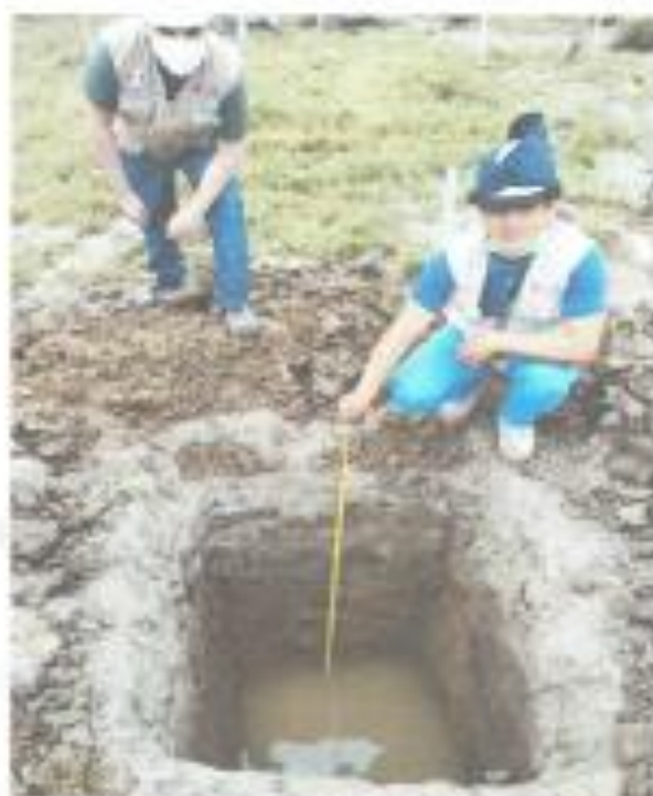
Foto N°05. Ubicación y apertura del suelo en calicata C-3 notándose el nivel freático. Coordenas WGS 84. Este: 825813.983, Norte: 8244615.758.
