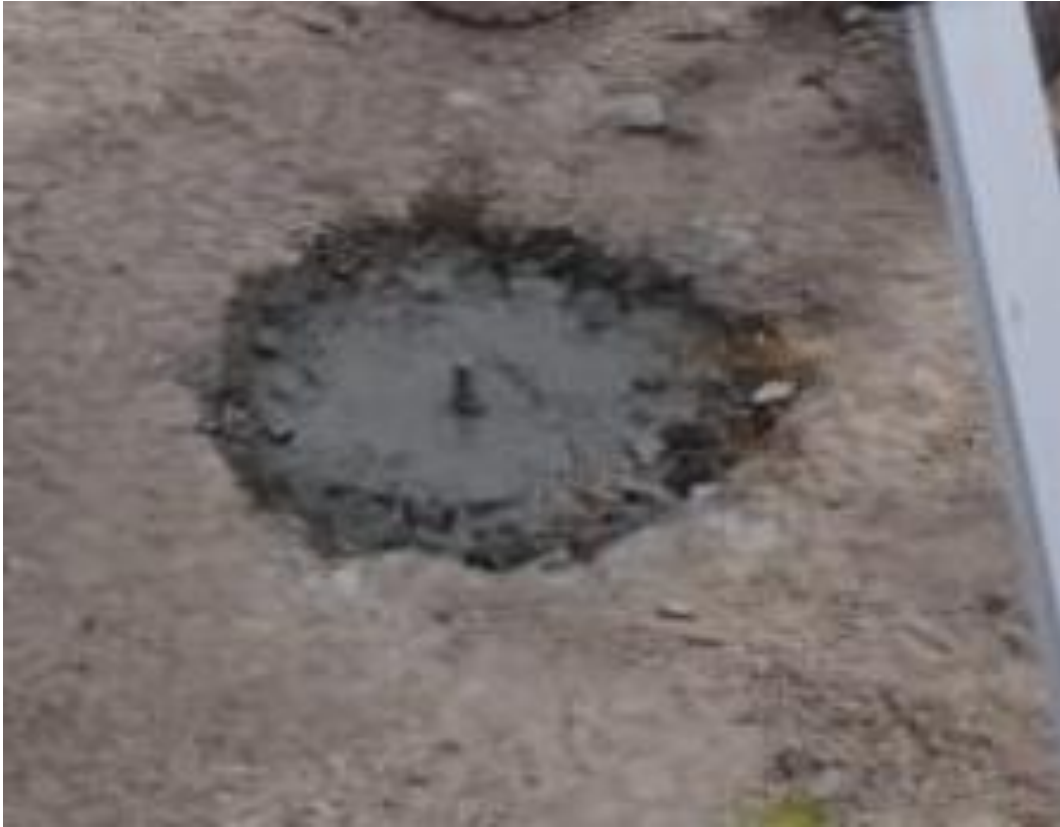
Foto 3. Vista del BM 01.
