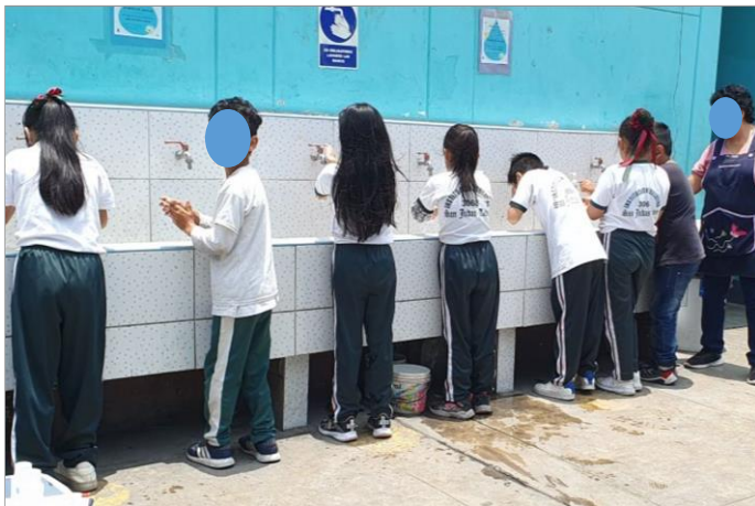
Foto 6. Uso de lavadero externo y acopio de aguas grises
