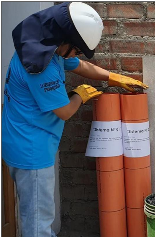
Foto 1. Habilitación de dos tubos PVC de 160 mm de diámetro (Ø6" efectivas). Para esta tarea, se adquirieron todos los accesorios necesarios en una ferretería local.
