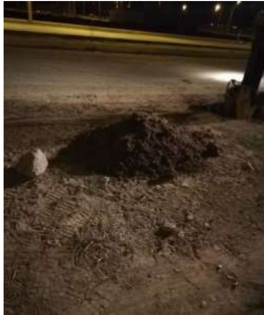
Figura 8. Excavación para muestra Fuente: Elaboración propia
