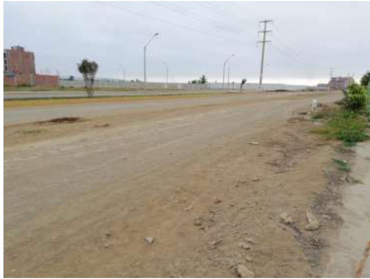
Fotografía 1: Vista panorámica de la Avenida Circunvalación Sur
