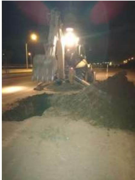
Fotografía 3: Excavación de la muestra de la Subrasante
