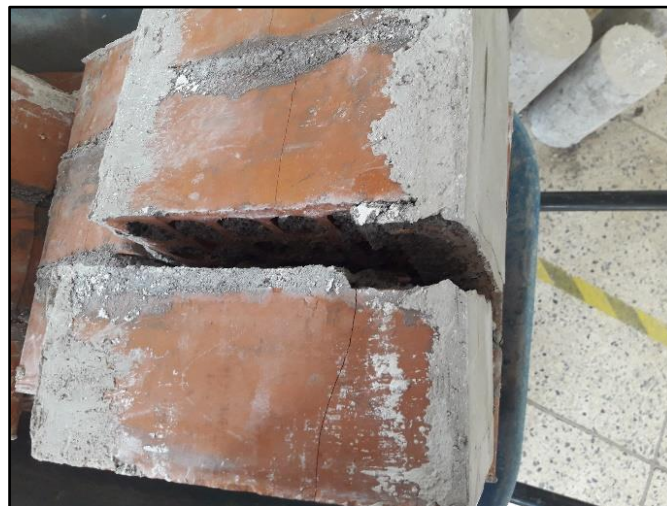
Figura 72. Falla después del ensayo de adherencia a cizalle.
