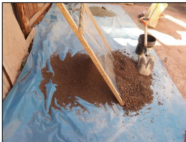
Figura 49. Preparación de los agregados.
