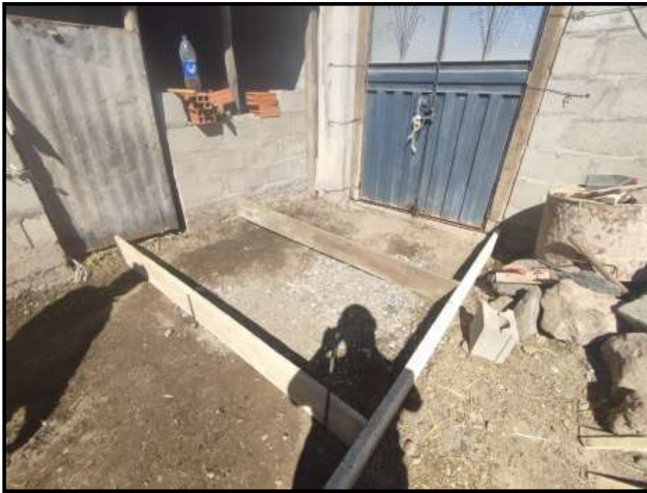
Fotografía 12. Encofrado y vaciado de Paños de prueba 2x1m
