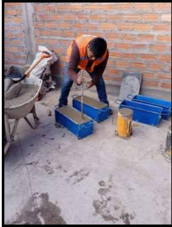
Fotografía 7. Elaboración de vigas
