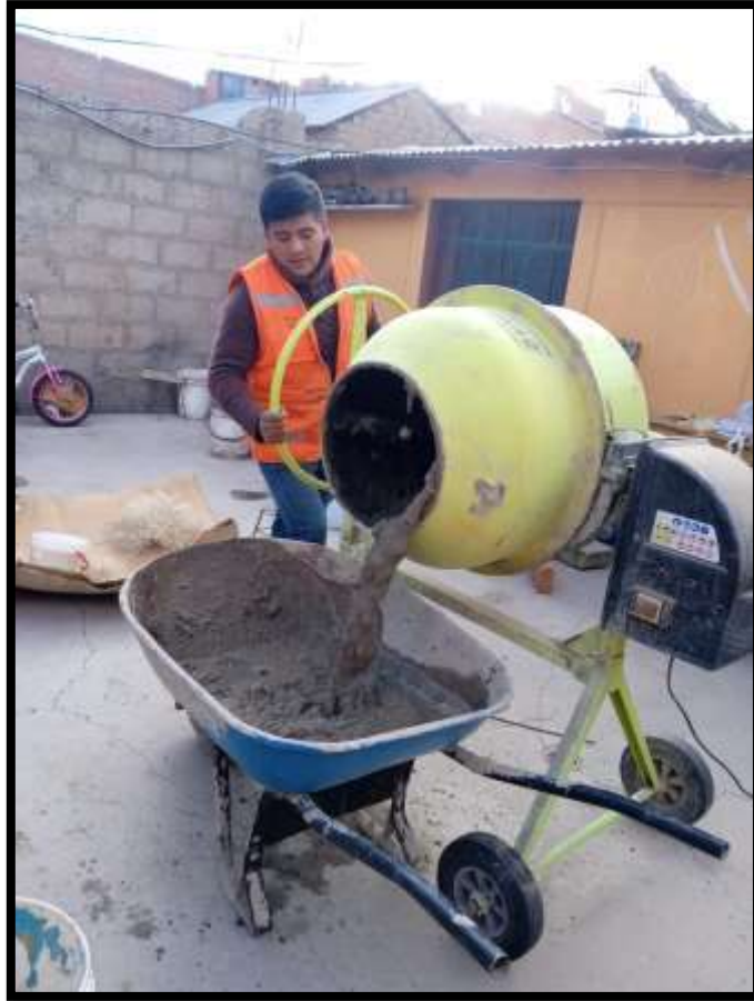
Fotografía 3. Preparación de mezcla
