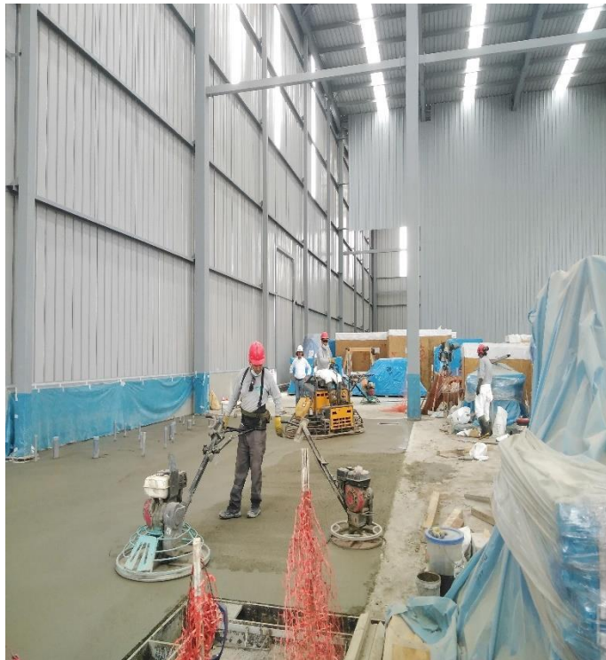
Acabado de la losa de concreto con fibra metálica
