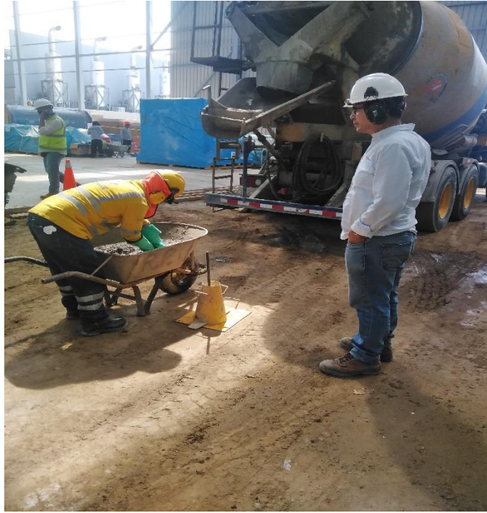
Toma de muestra de concreto
