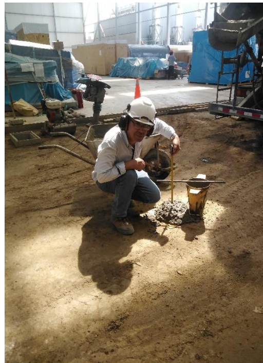
Medida del asentamiento del concreto
