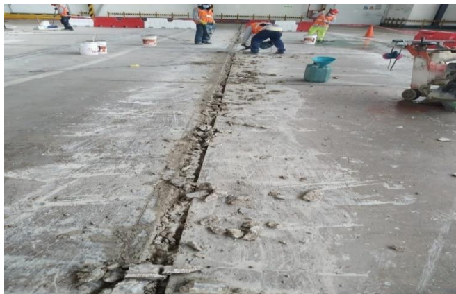
Fig. 03 Reparación de juntas de contracción
