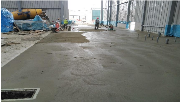
Vaciado de concreto con fibra de losa con juntas en proceso de pulido
