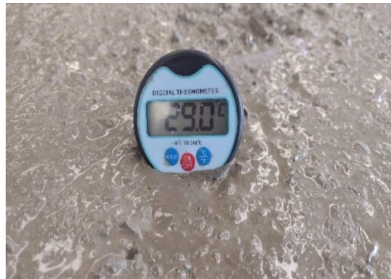
Fig. 12 Medida de la temperatura del concreto
