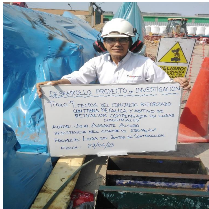
Moldes prismáticos para ensayo de resistencia a flexión del concreto
