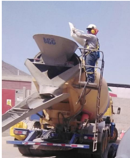
Fig.17 Adición de fibra metálica en obra
