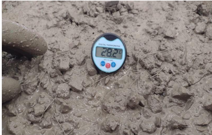
Medición de la temperatura del concreto con fibra metálica
