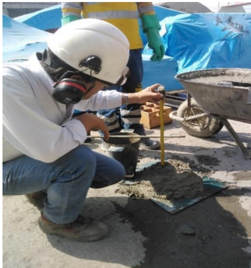
Fig. 11 Medida del Slump del concreto
