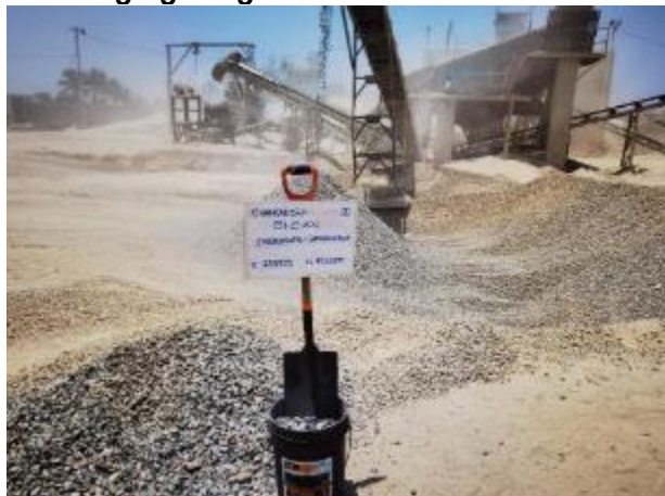
Foto 6. Agregado grueso – Chancadora “Sicán”
