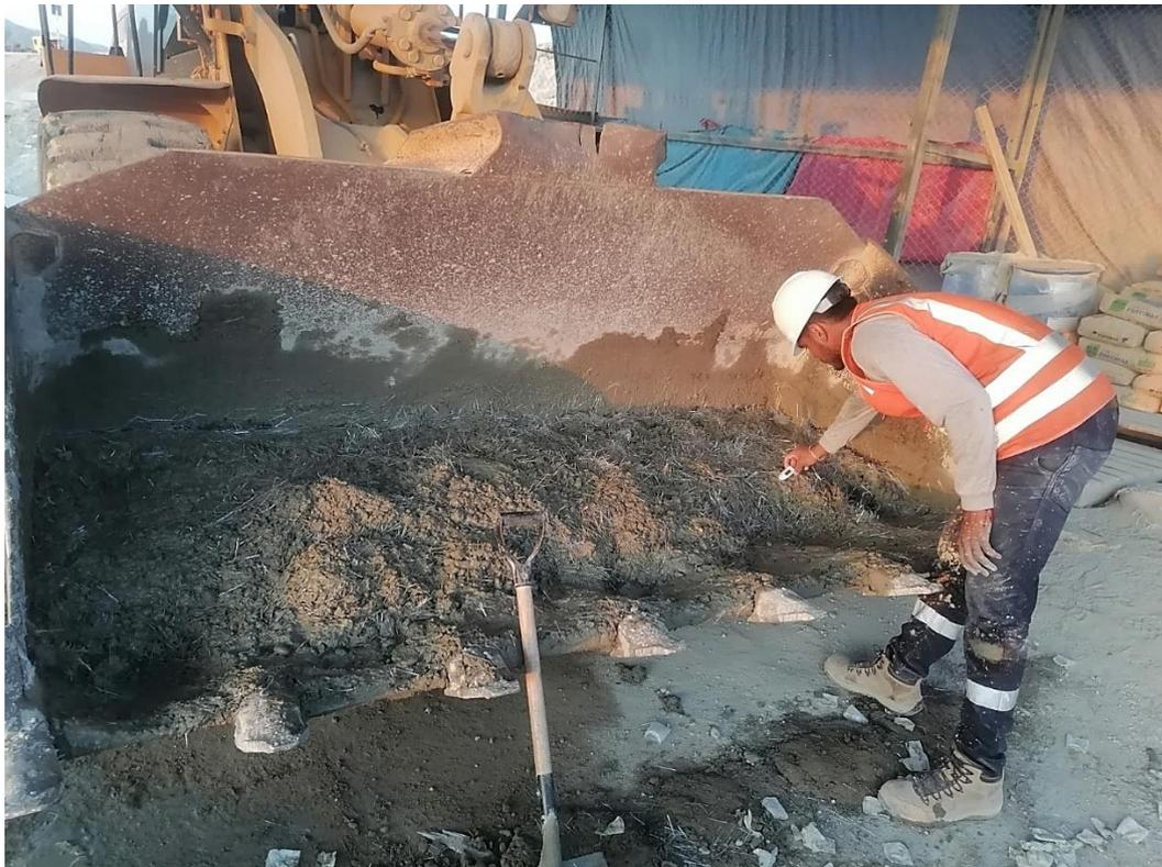
**Foto 4.** Toma de temperatura del concreto en estado fresco
