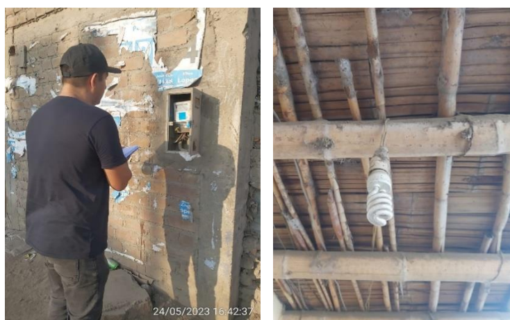
Figura 18. Inspección instalaciones eléctricas
