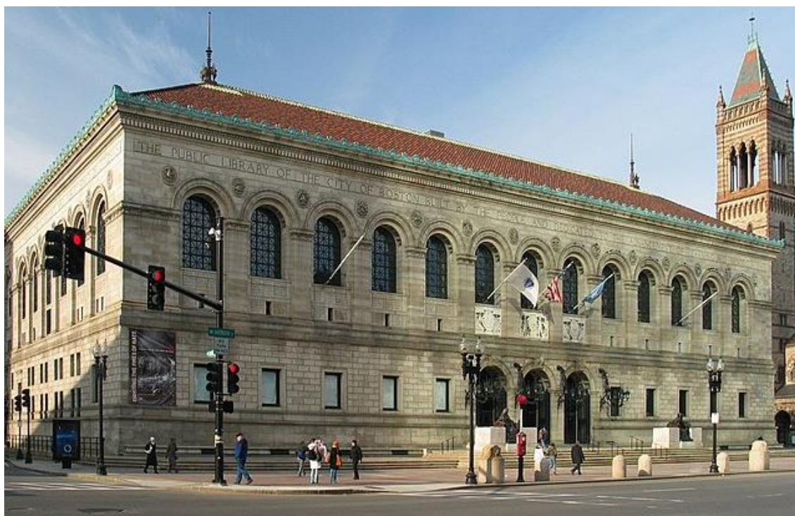
Figura 18. Biblioteca pública de la ciudad de Boston – EE.UU
