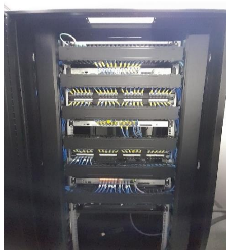
Figura 32: Instalación del Switch al Gabinete G3 - Hospitalización
