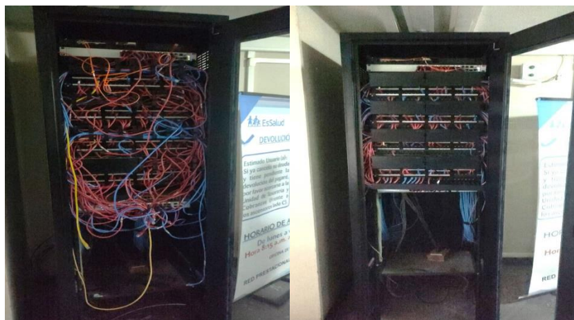
Figura 25: Instalación del Switch al Gabinete B
