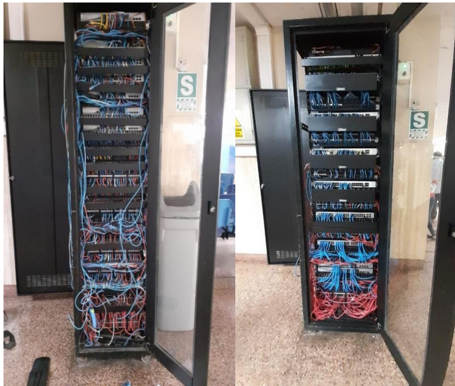
Figura 33: Instalación del Switch al Gabinete I1
