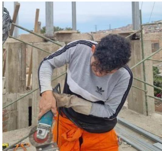
Los trabajos se realizan sin epps o solo con equipo de protección, pero de forma parcial, en este caso el colaborador está realizando trabajos en caliente sin el equipo correcto para este tipo de tareas.
