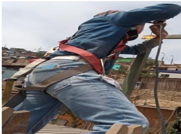
En esta imagen, podemos apreciar que se realiza trabajo de soldadura, el colaborador se encuentra anclado correctamente con su arnés, careta de soldar, capucha antiflama, pero no tiene Guantes de soldar y el mandil ignífugo para su protección corporal.
