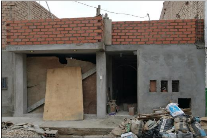
Vista de la vivienda, materia de la presente investigación
