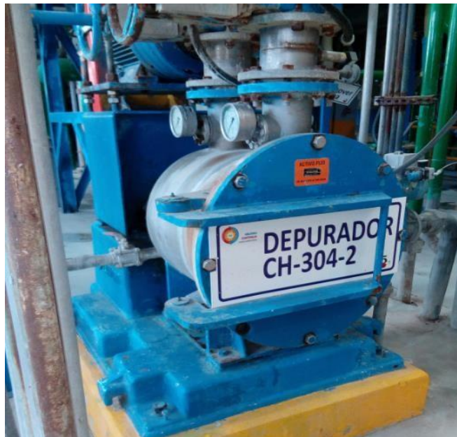
Figura 41: sistema de aire comprimido
