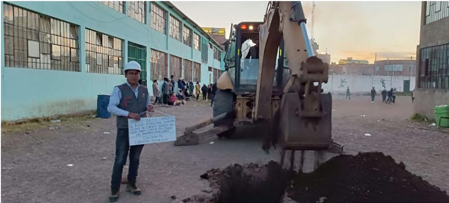
*Excavación de calicata N° 02 a una profundidad de 2.30m*
