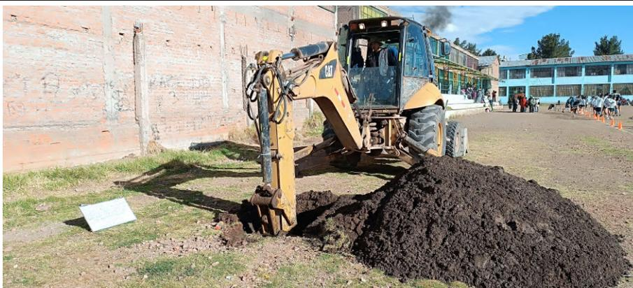
*Excavación de calicata N° 01 a una profundidad de 2.00m.*
