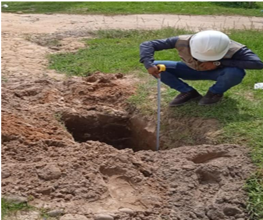
Figura 9. Verificación de medidas correspondientes de la calicata N°04.
