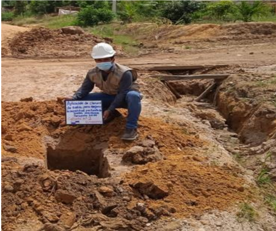
Figura 4. Excavación de calicata N°02
