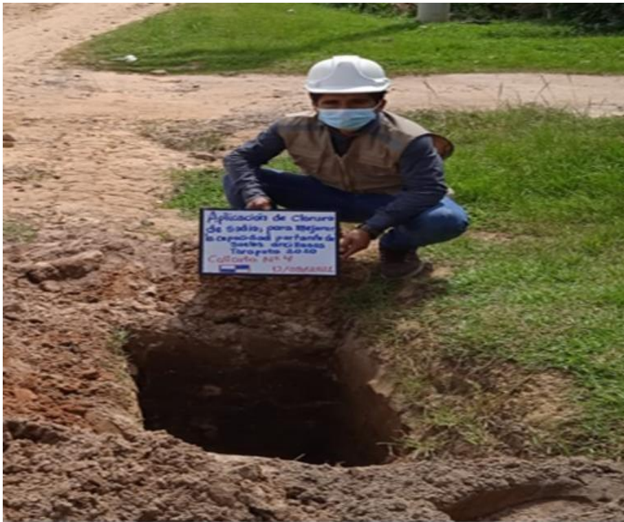
Figura 8. Excavación de la calicata N°04.
