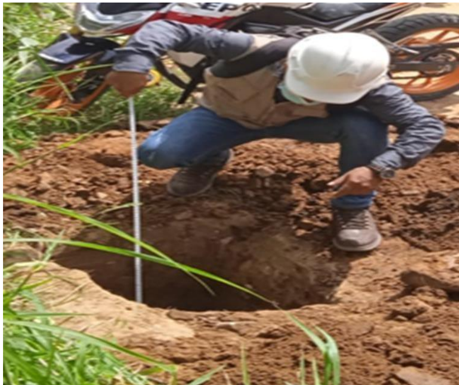
Figura 7. Verificación de medidas correspondientes de la calicata N°03.
