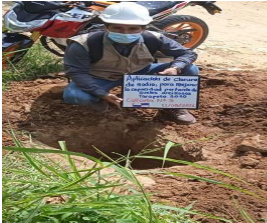
Figura 6. Excavación de la calicata N°03.
