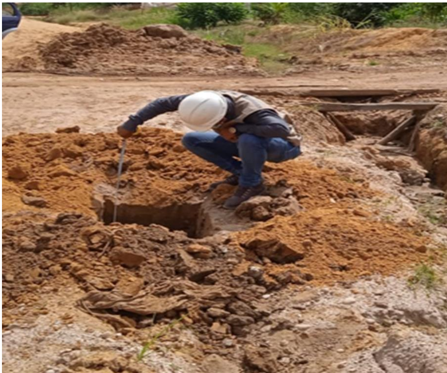
Figura 5. Verificación de medidas correspondientes de la calicata N°02.
