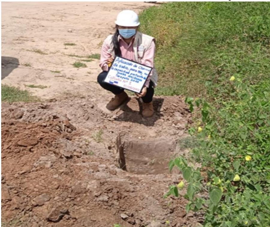
Figura 2. Excavación de calicata N° 01.
