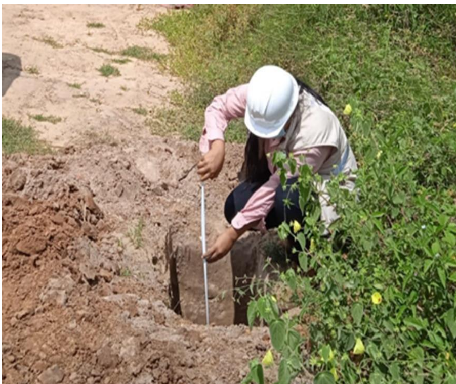
Figura 3. Verificación de medida correspondiente de calicata N°01.
