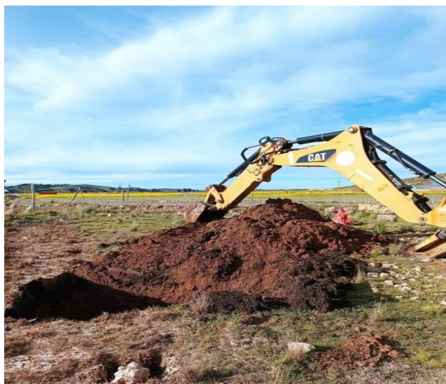
Excavación en C-4
