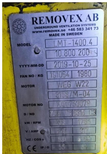
Figura 1. Datos del motor del ventilador principal
