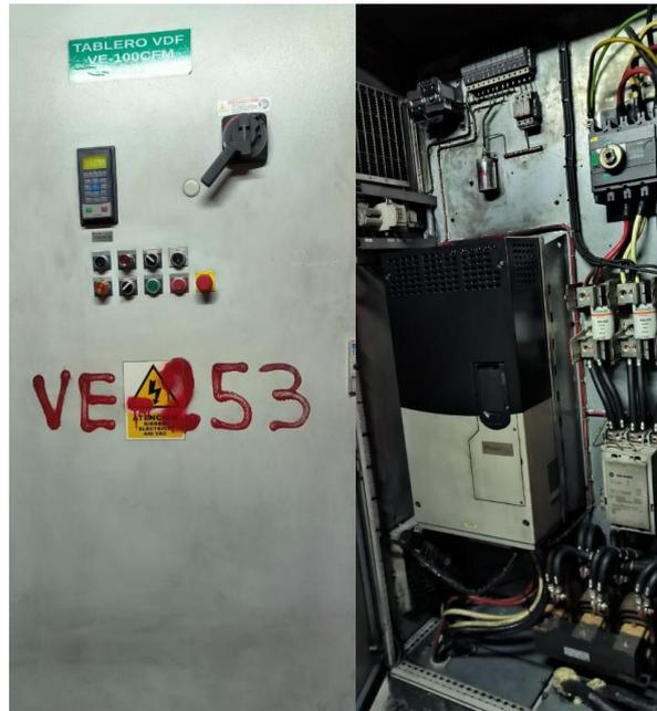
*Figura 17.* Variador PowerFlex 755 montado en tablero de potencia en campo.
