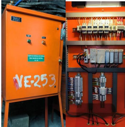
*Figura 18.* Sistema de control montado en tablero de control en campo.
