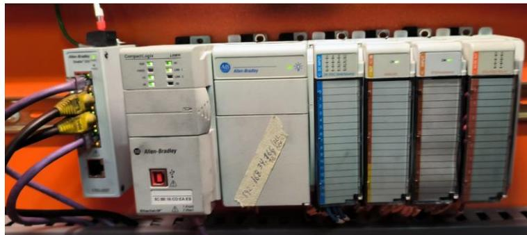
*Figura 19.* PLC Compact Logix montado en tablero de control en campo.
