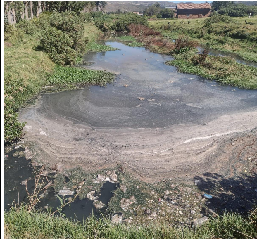
Figura 2. Toma panorámica de la salida del pozo de oxidación 02.
