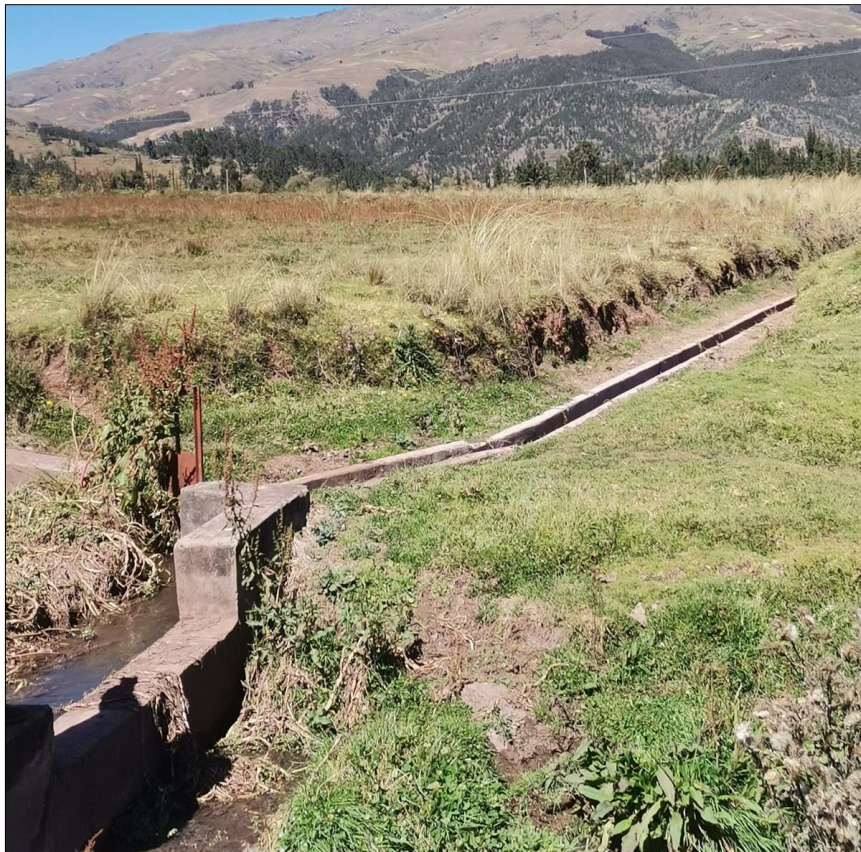
Figura 29. Canal de riego del Proyecto “Mejoramiento del sistema de riego en los sectores Sondor 1, Sondor 2 Y Banco Centro de la Comunidad Campesina de Circa Kcacya del distrito de Ancahuasi - Anta – Cusco”
