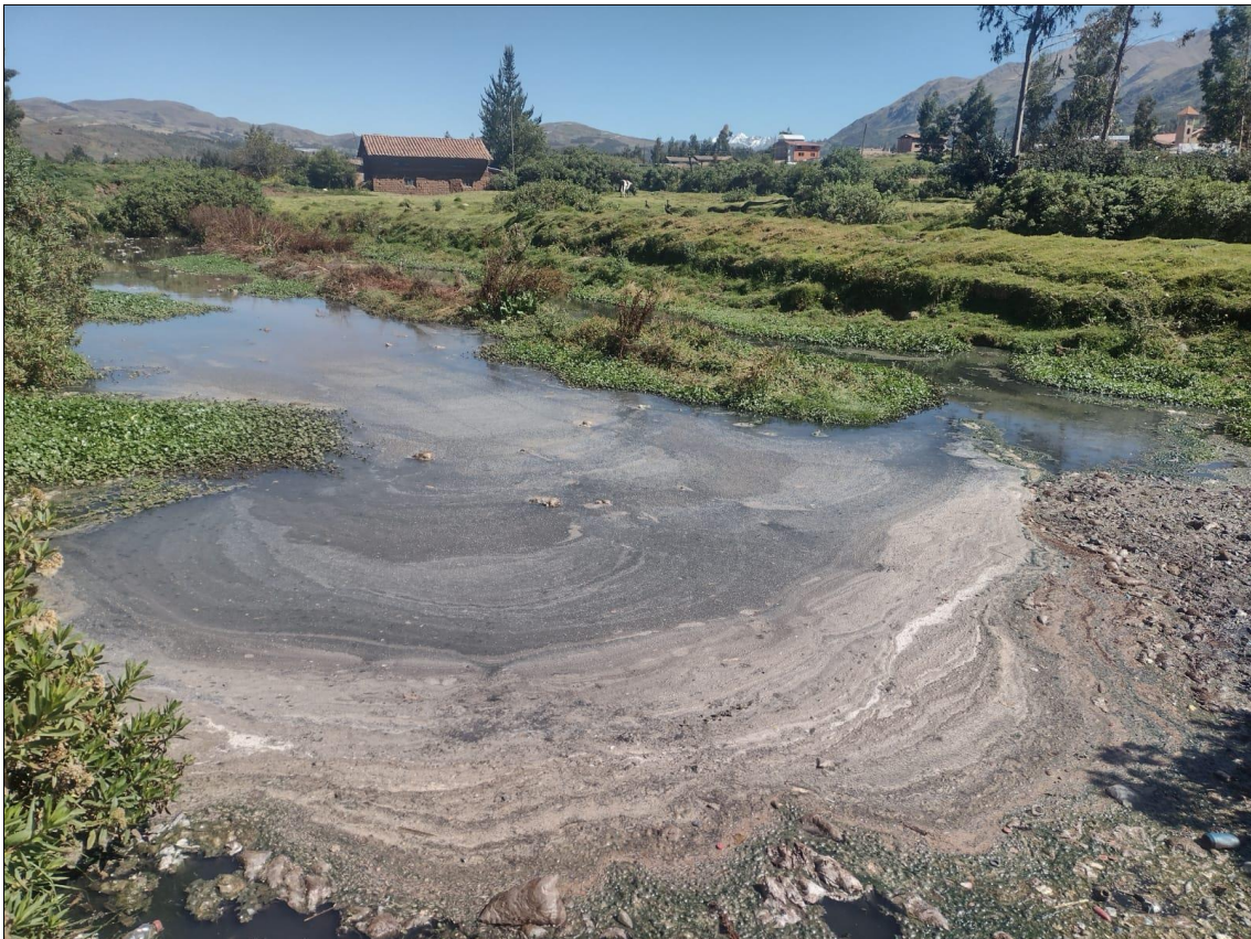
Figura 25. Situación de los Pozos de Oxidación 1 y 2
