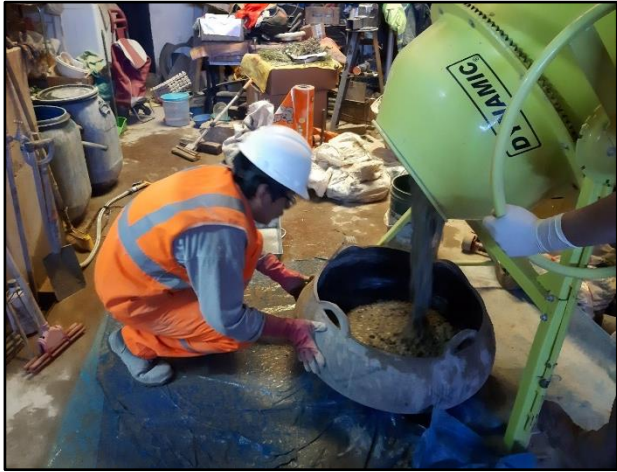
Imagen 42. Vaciado de la mezcla de concreto autocompactante.
