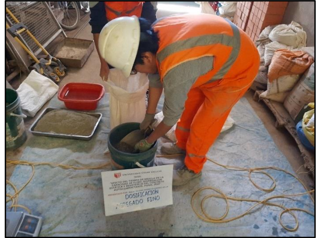
Imagen 37. Dosificación de agregado fino.
