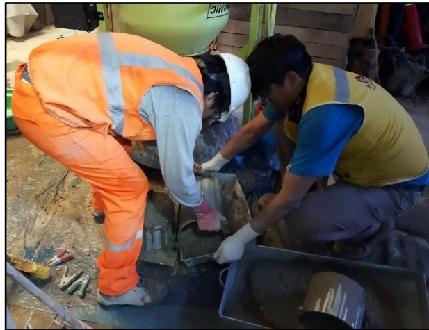
Imagen 50. Desmontaje secuencial de columna de segregación.
