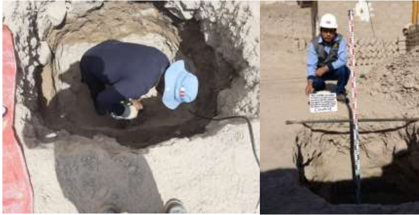
Figura 4. Excavación de la calicata a una profundidad de 3.00m
