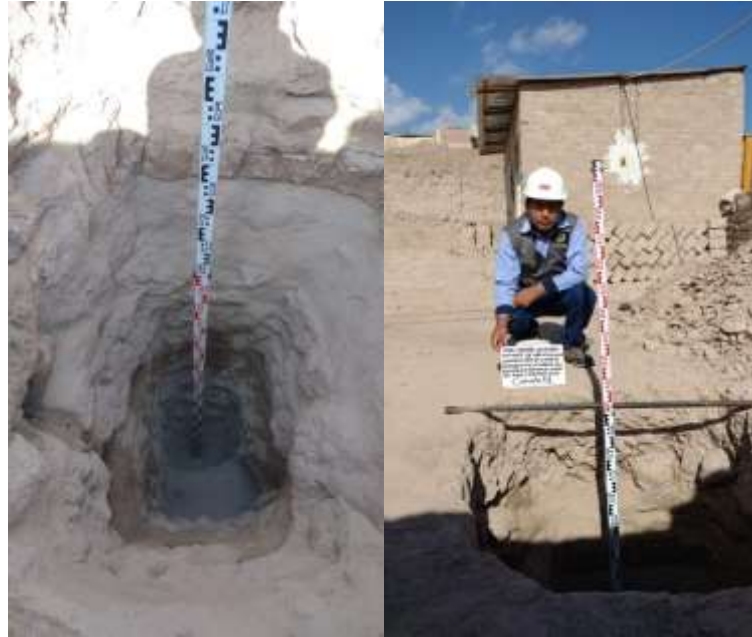
Figura 30. Calicata 1 para estudiar las características mecánicas del suelo
