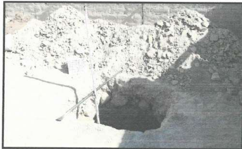
figura 3.- Muestreo de material en la calicata C-01.
