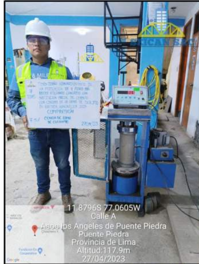
Fotografía N. 80: Rotura de probetas 6"x12" a 7 días
