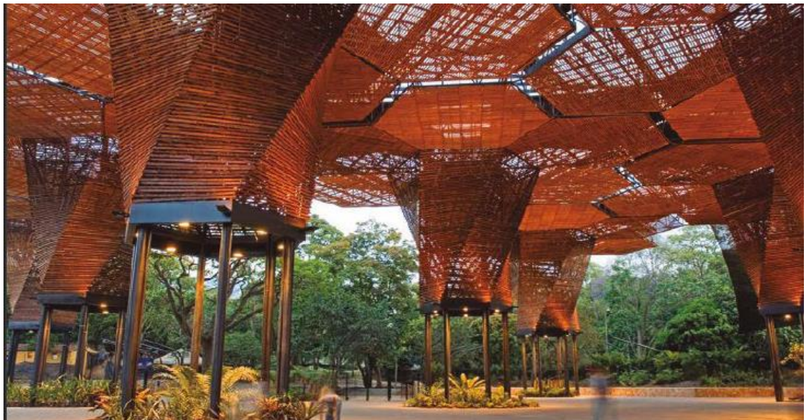
Cubiertas con alturas que imitan arboles
