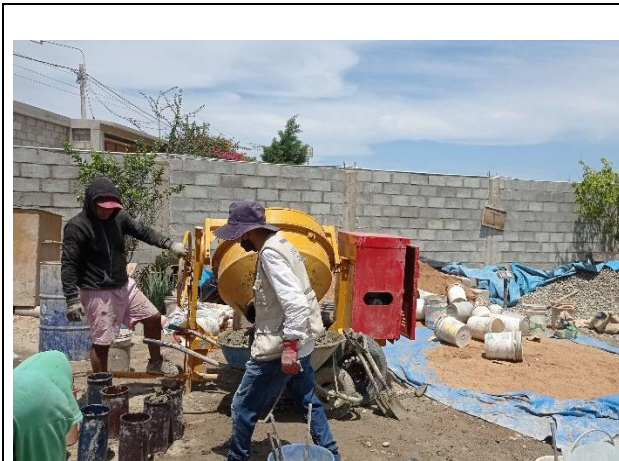
Foto N°1 Pesado de agregados
