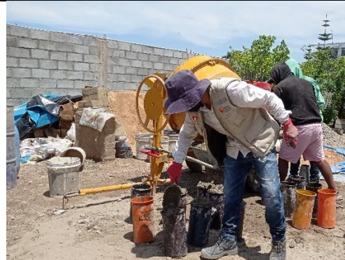
Foto N°4 Vaciado en probetas y chuceado
