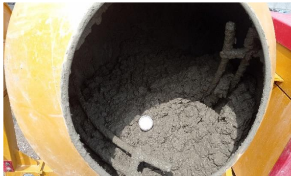
Foto N°3 Mesclado de agregados
