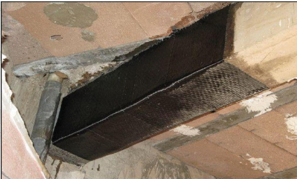
Figura N° 2: Encamisetado de muro confinado
