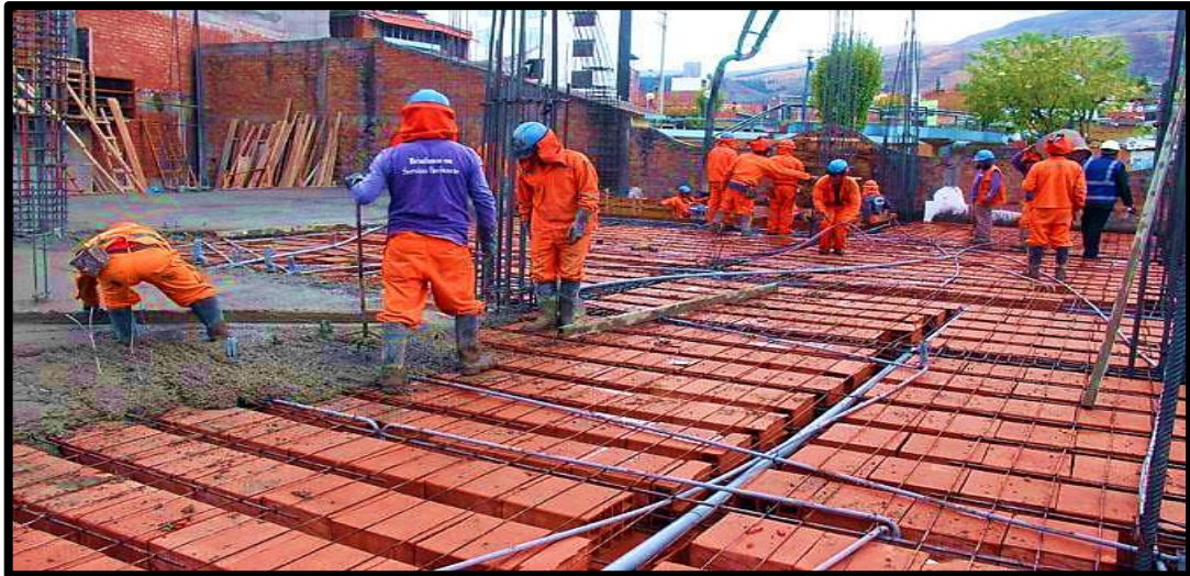
Figura 5. Vaciado de concreto para losa aligerada
