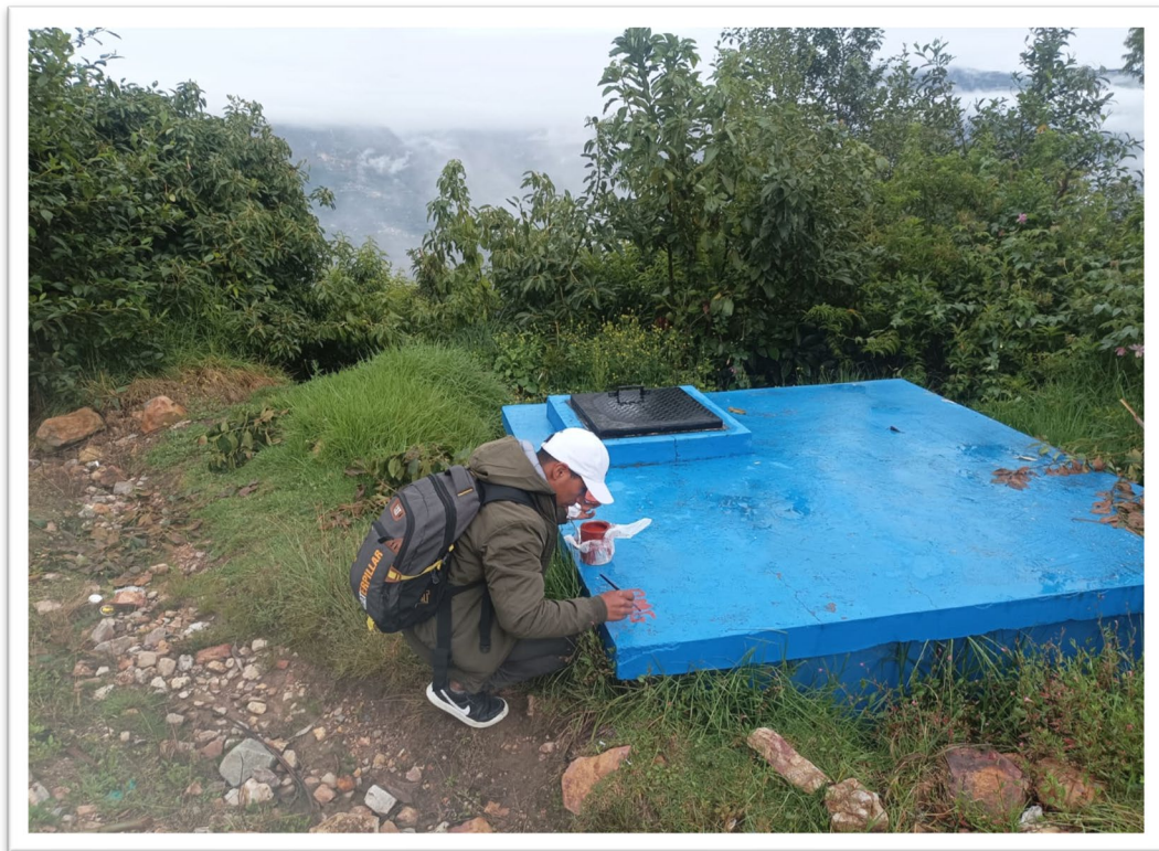
FOTOGRAFIA 11: TANQUE DE ROMPE PRESION EXISTENTE DONDE SE DEJA BM.
