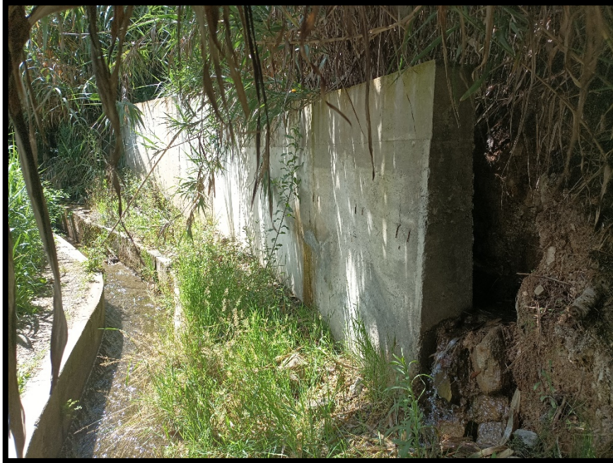
FOTOGRAFÍA N° 13: Verificación del estado actual de la captación existente
