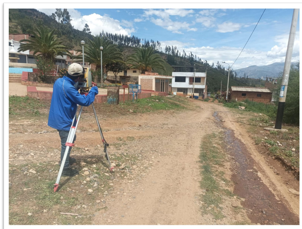
FOTOGRAFIA 06: REALIZACION DEL LEVANTAMIENTO TOPOGRAFICO EN EL PUEBLO PARA LA RED DE DISTRIBUCION.
