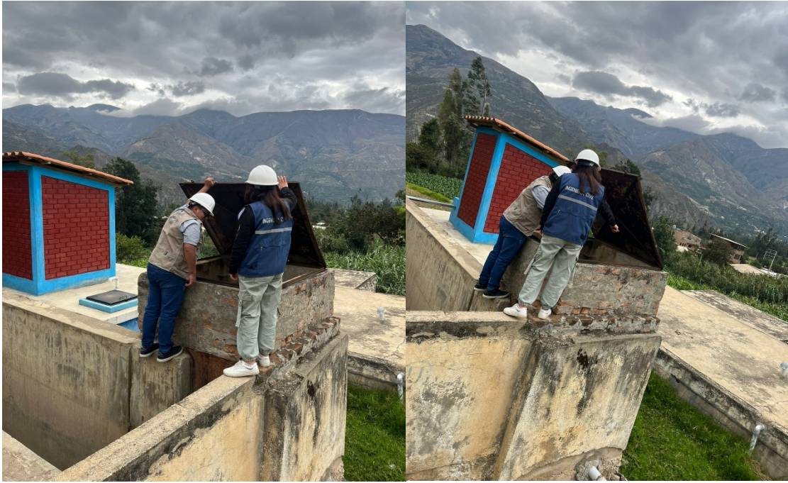
FOTOGRAFÍA N° 21: Verificación del reservorio actual.
