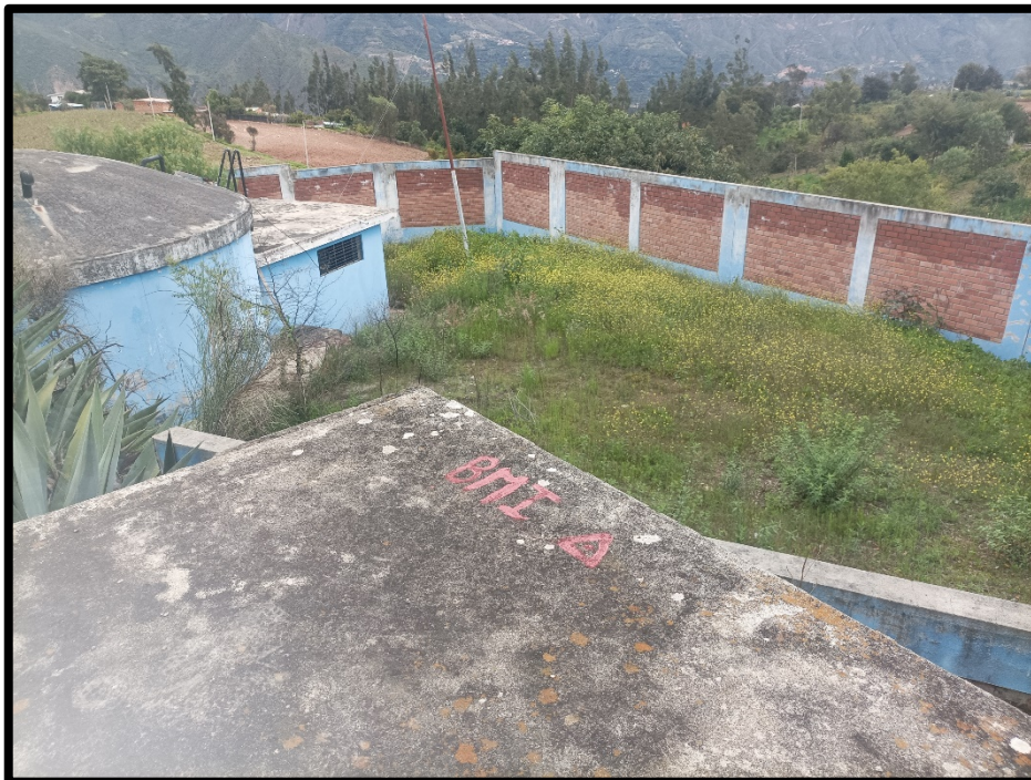
FOTOGRAFÍA N° 18: Verificación del área de terreno destinado para la ubicación de la estructura de filtro lento
