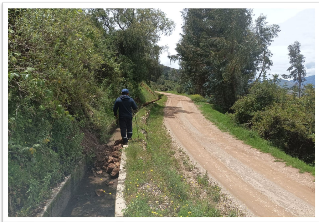
FOTOGRAFIA 05: SE VERIFICA EL RECORRIDO DE LA CONDUCCION DEL AGUA POTABLE
