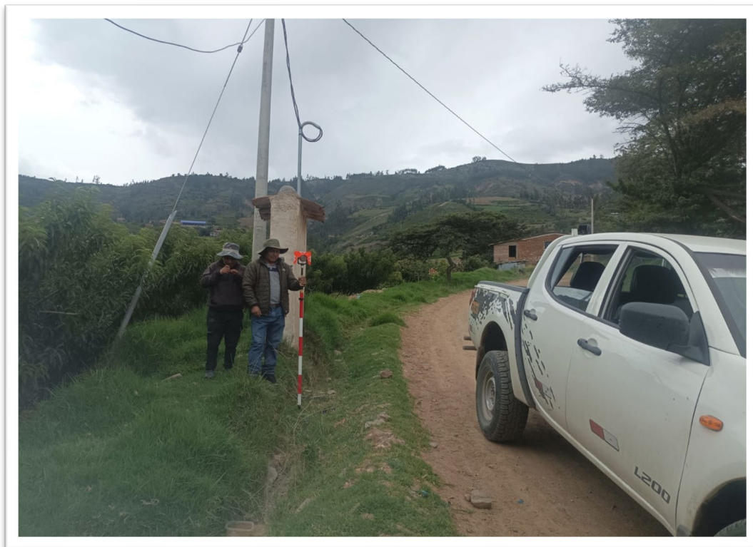
FOTOGRAFIA 08: SE APRECIA LUGAR POR DONDE SE VA A TRANSPORTAR EL AGUA
