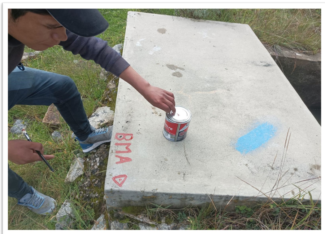
FOTOGRAFIA 12: OBSERVAMOS LA COLOCACION DE BM. PARA SU POSTERIOR TRAZO Y REPLANTEO
