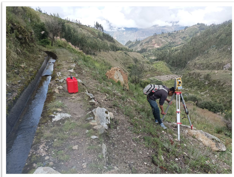
FOTOGRAFIA 04: SE OBSERVA LA NIVELACION DE LA ESTACION TOTAL.
