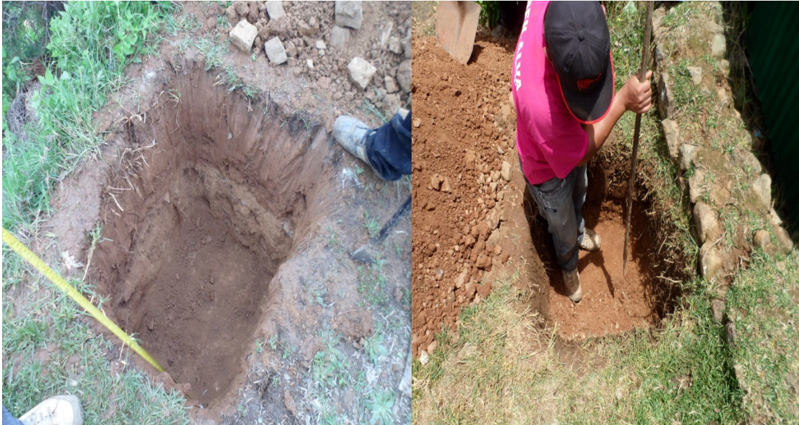
FOTOGRAFÍA N° 27: Excavación de las calicatas.
