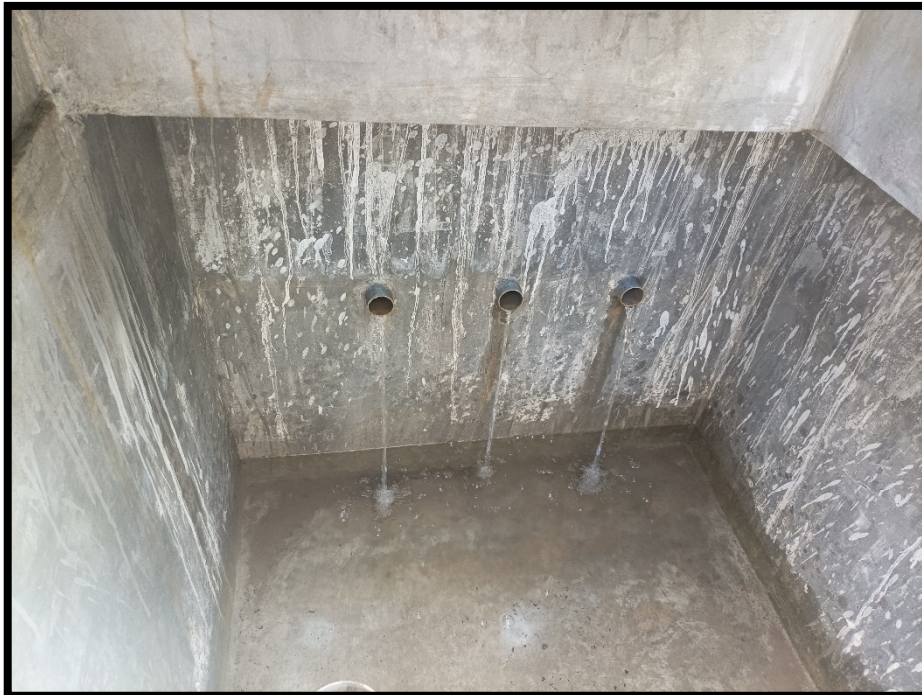
FOTOGRAFÍA N° 14: verificación y aforo del caudal actual
