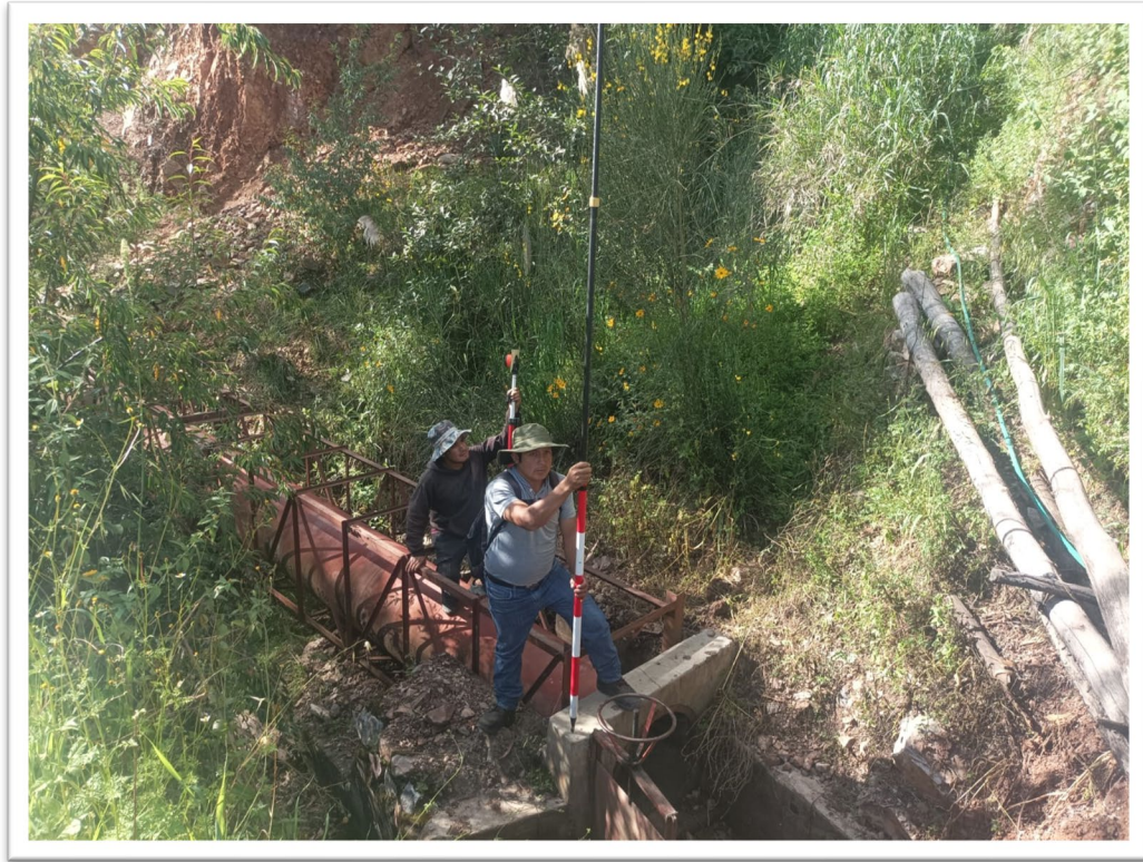
FOTOGRAFIA 07: SE APRECIA PUENTE AEREO DEBIDO A LA FALLA GEOLOGICA
