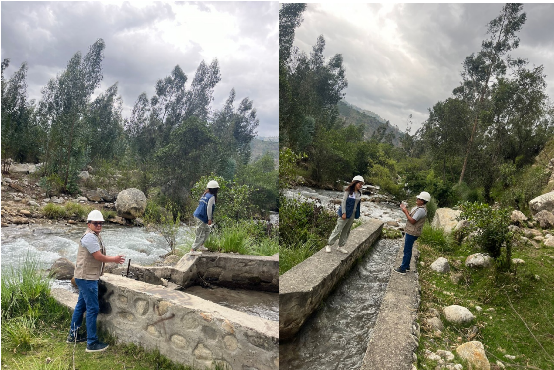
FOTOGRAFÍA N° 24: Parte de la captación donde se saca la muestra de agua.
