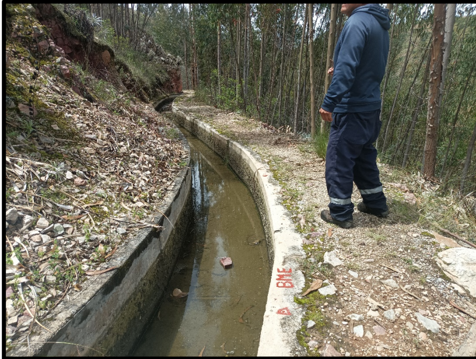
FOTOGRAFÍA N° 17: Recorrido y verificación de la línea de conducción proyectado.
