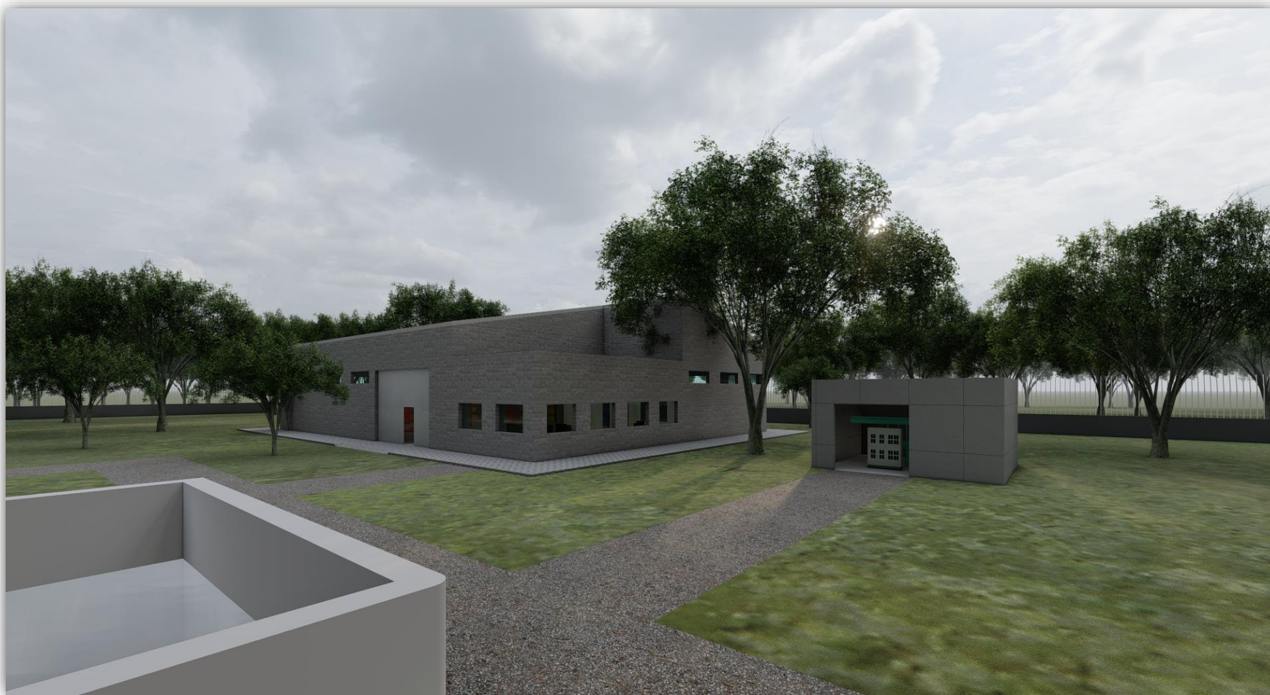
Elaboración propia: Cuarto donde se debe ubicar el centro de control
