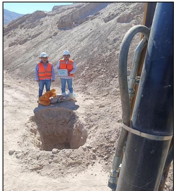
**Foto 03,04:** Excavación de calicatas con maquinaria pesada.
