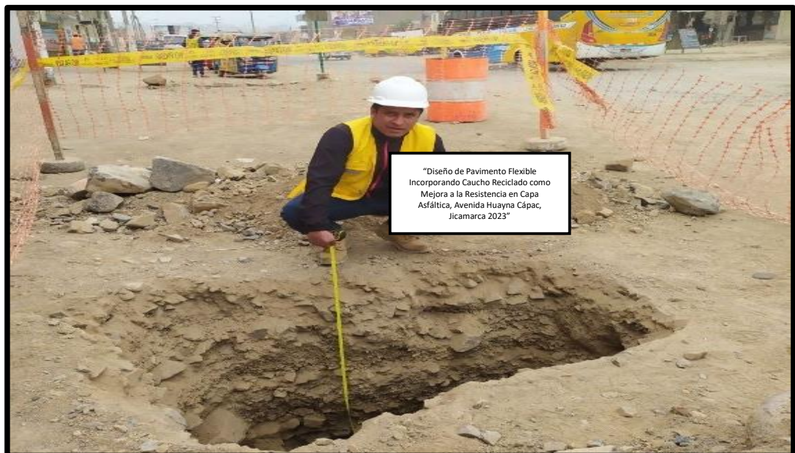
Figura 4. Calicata C – 01 con una dimensión de 1.5m x 1m.
