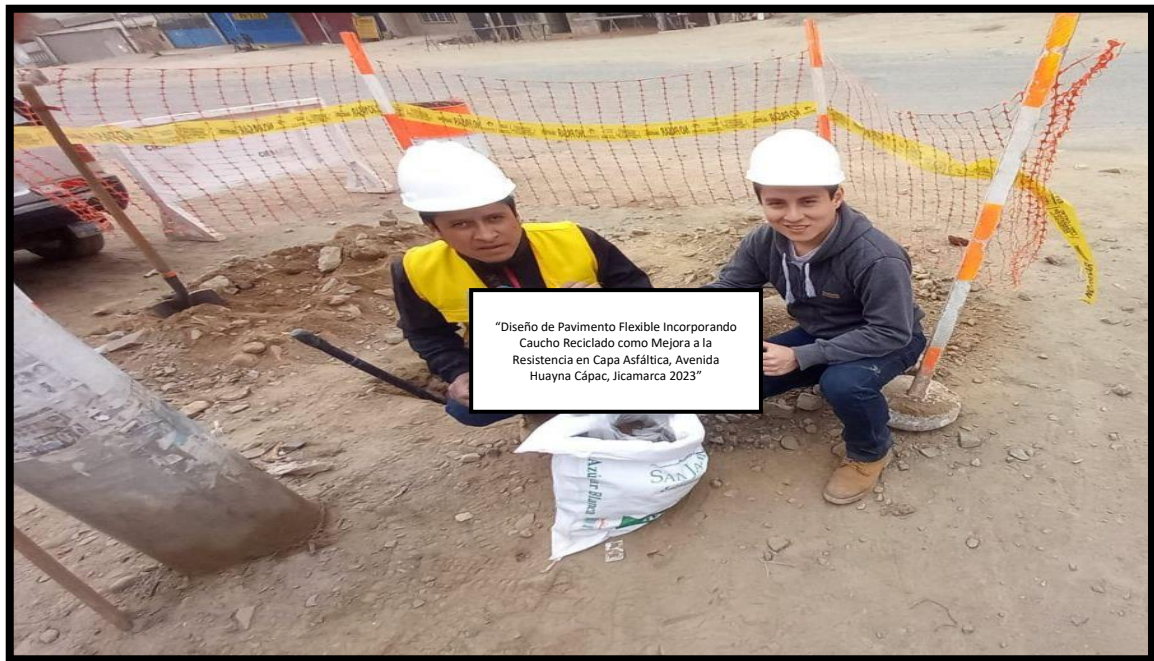
Figura 5. Calicata C – 02 con una dimensión de 1.2m x 1m
