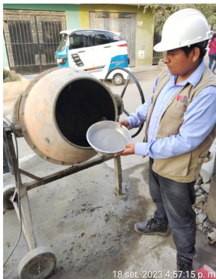
Vaciado de concreto Cenizas de Carbon vegetal – Cenizas de Carrizo
