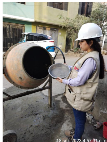
Vaciado de concreto Cenizas de Carbon vegetal – Cenizas de Carrizo
