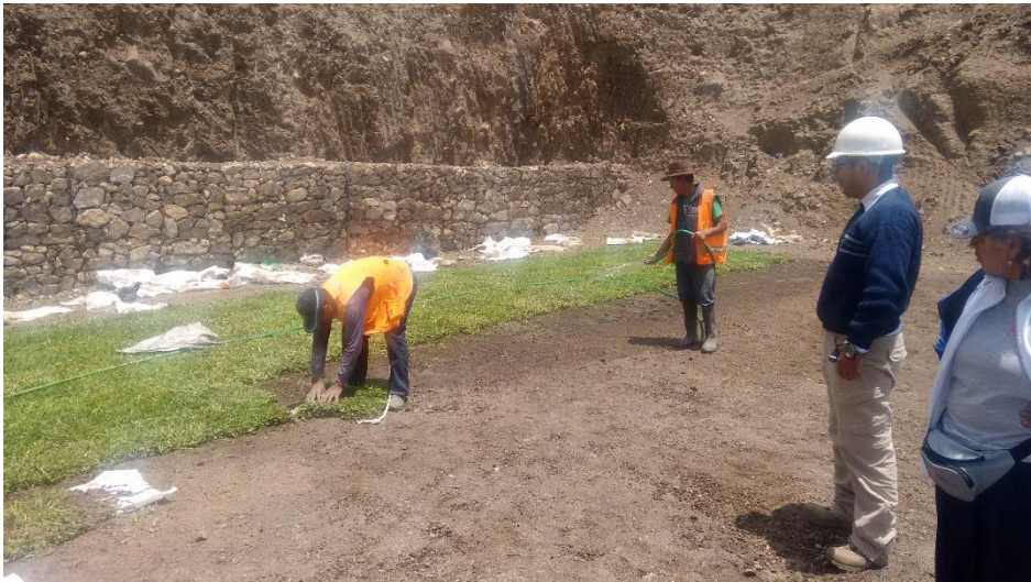
Figura 25. Indicaciones del ingeniero residente para la buena colocación del grass natural.
