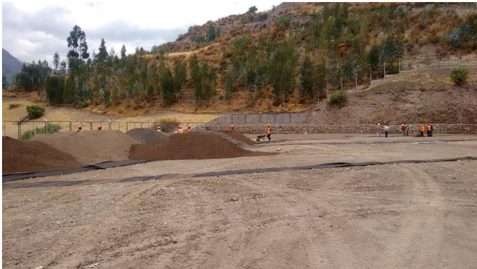
Figura 10. Abastecimiento de material seleccionado para el campo deportivo.
