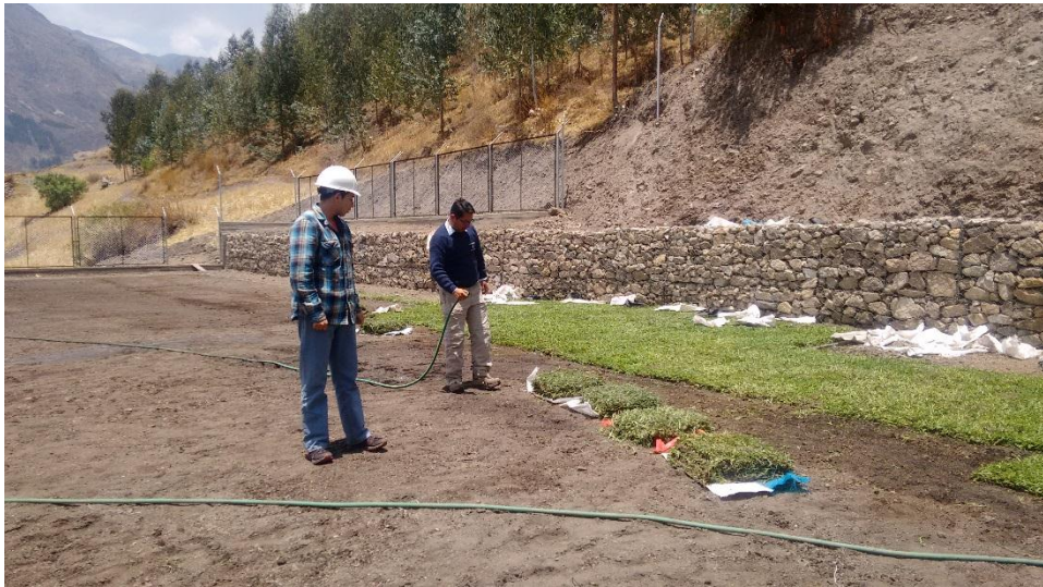
Figura 22. Colocado del grass natural.
