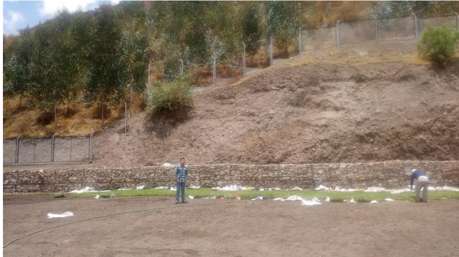
Figura 24. Colocación del grass natural.
