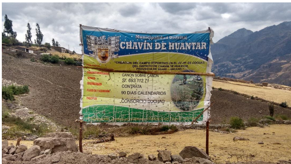
Figura 20. Cartel de la obra en estudio.
