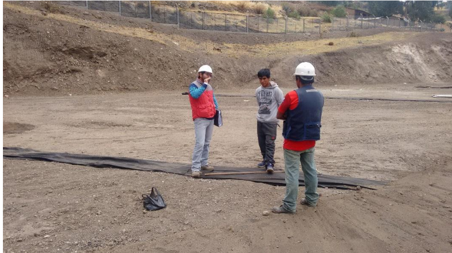
Figura 16. Reunión semanal para la planificación de los trabajos a ejecutar.
