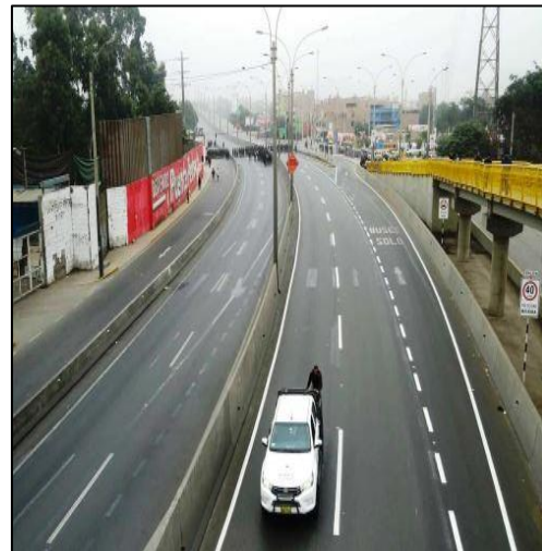
Figura 4. Carretera Panamericana Norte en Puente Piedra.
