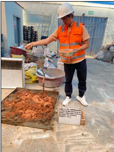
Figura 21. Proceso de mezclado del adobe
