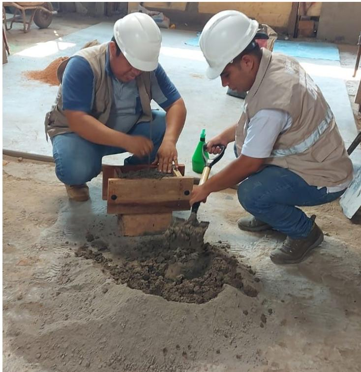
Foto 13. Proceso de llenado de los moldes de ladrillo.
