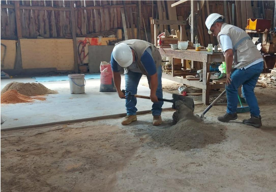
Foto 12. Proceso de llenado de los moldes con la mezcla.
