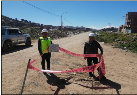
Figura 9. Zona señalización para la realización de calicata N°02, km 1+000
