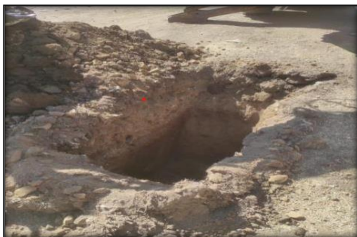
Figura 11. Extracción de muestra en la Av. Industrial (Calicata N° 02) de la progresiva km1+000.
