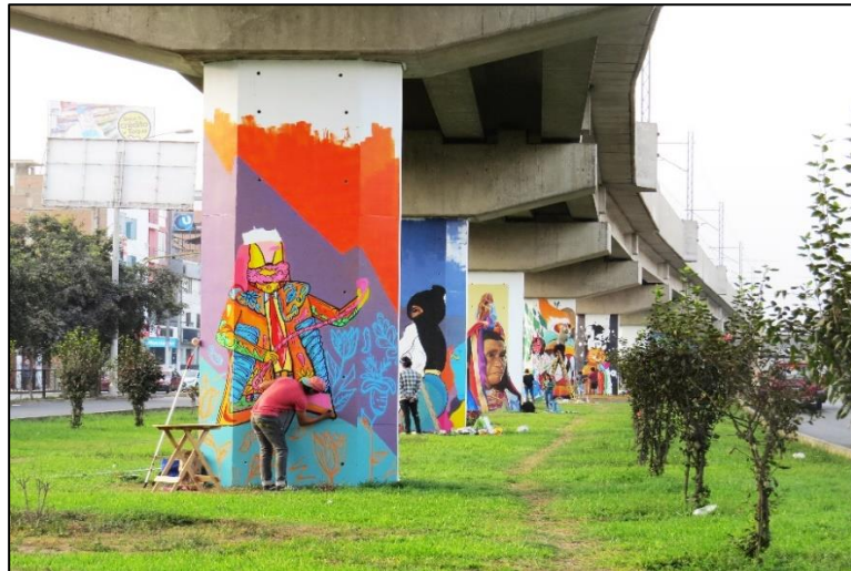
Figura 8. Intervención en las columnas del Metro de Lima LÍNEA 1
