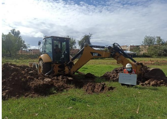
Fotografía 02. Excavación Calicata 02
