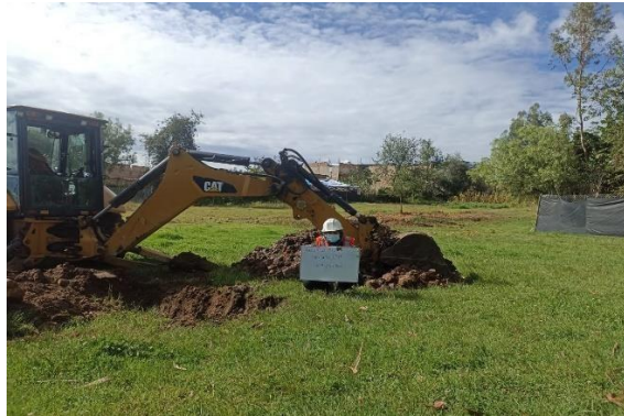
Fotografía 04. Excavación Calicata 04
