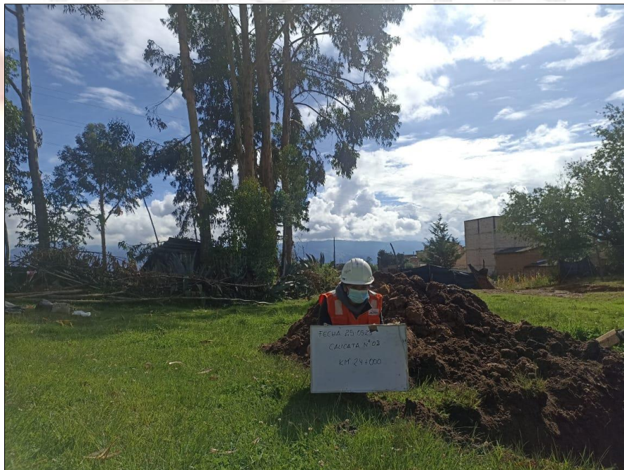
fotografía 02: se muestra la ubicación de la calicata N°02
