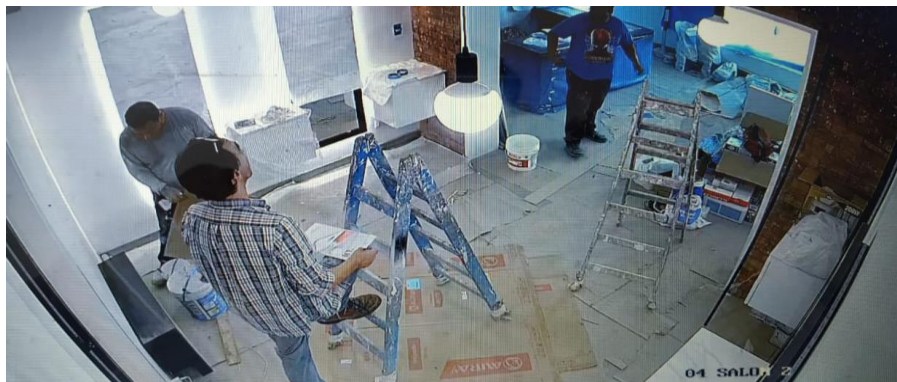
Figura 13. supervisión de operarios
