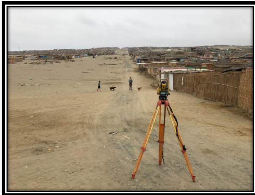
FOTO N°02: El personal topográfico ubicado en puntos estratégicos para el levantamiento topográfico.
