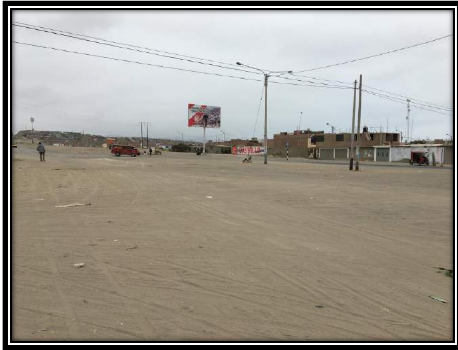
FOTO N°07: En esta imagen se muestra que el terreno presenta postes de alumbrado público dentro de sus límites.
