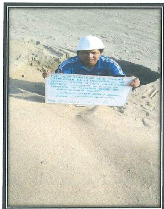
FOTOS N° 23, 24 Excavación manual de calicata N° 06
