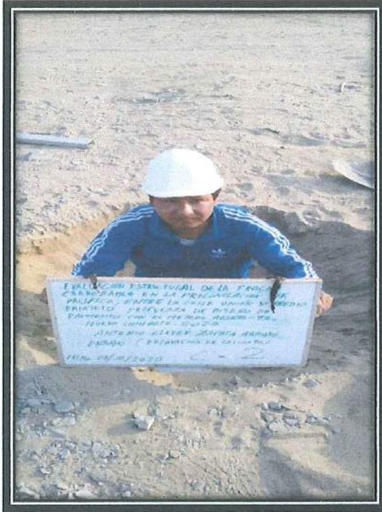
FOTOS N° 05, 06 Excavación manual de calicata N° 02
