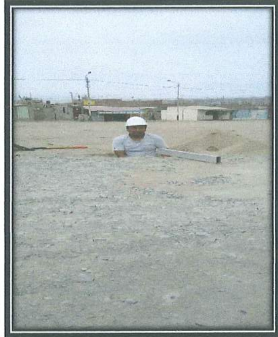
FOTOS N° 01, 02 Excavación manual de calicata N° 01
