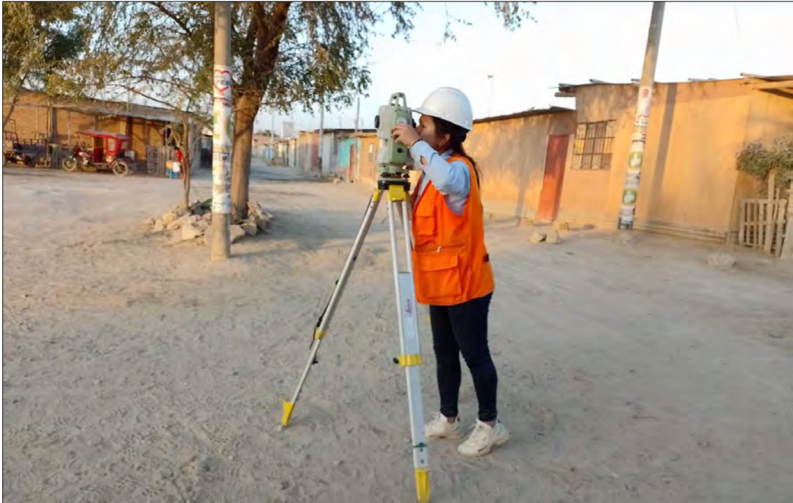
Figura 16. Proceso de levantamiento topográfico
