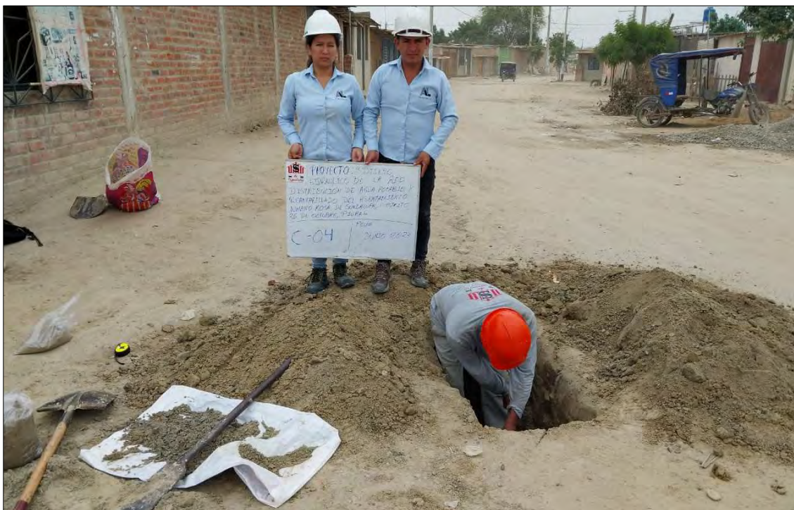
Figura 23. Proceso de elaboración de la calicata N° 4
