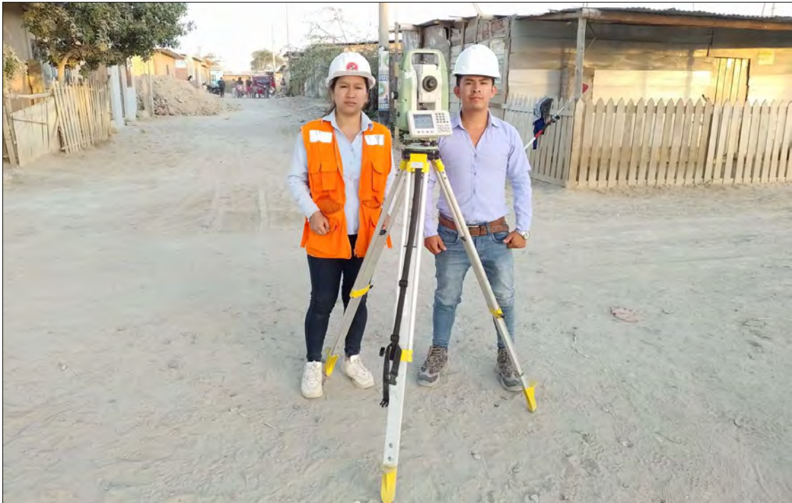
Figura 17. Estación total utilizada para el levantamiento topográfico
