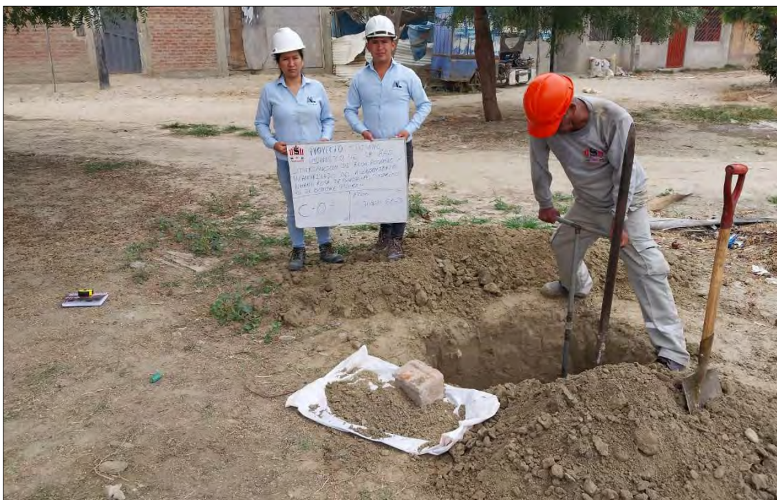
Figura 22. Proceso de elaboración de la calicata N° 3
