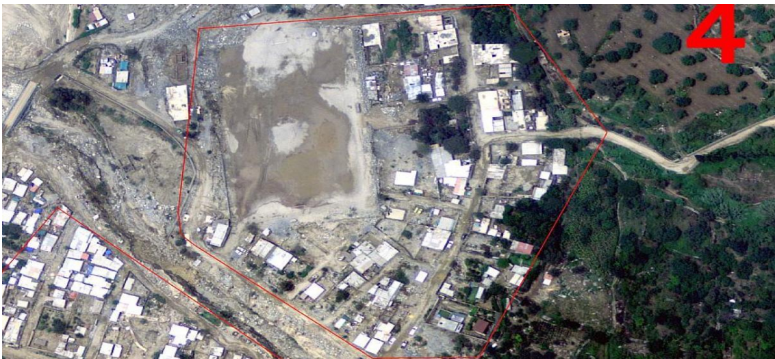
Figura N° 41 Viviendas y áreas de cultivo Afectada
