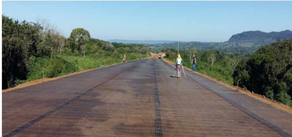
Figura 2: Aplicación de geomallas.
