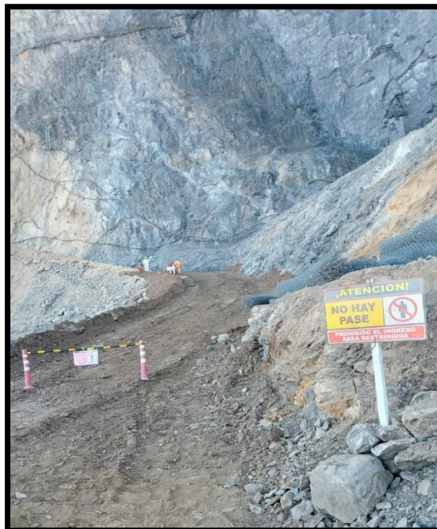
Vista al área del estudio geomecánico
