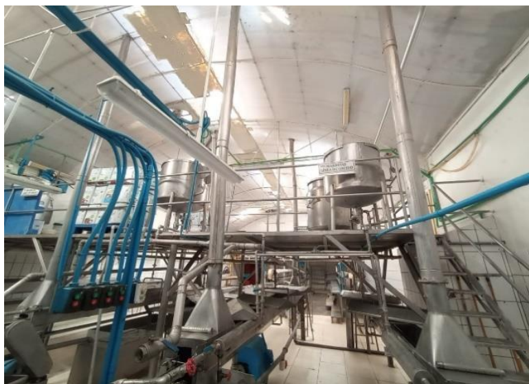
Figura 4. Mantenimiento de Marmita
