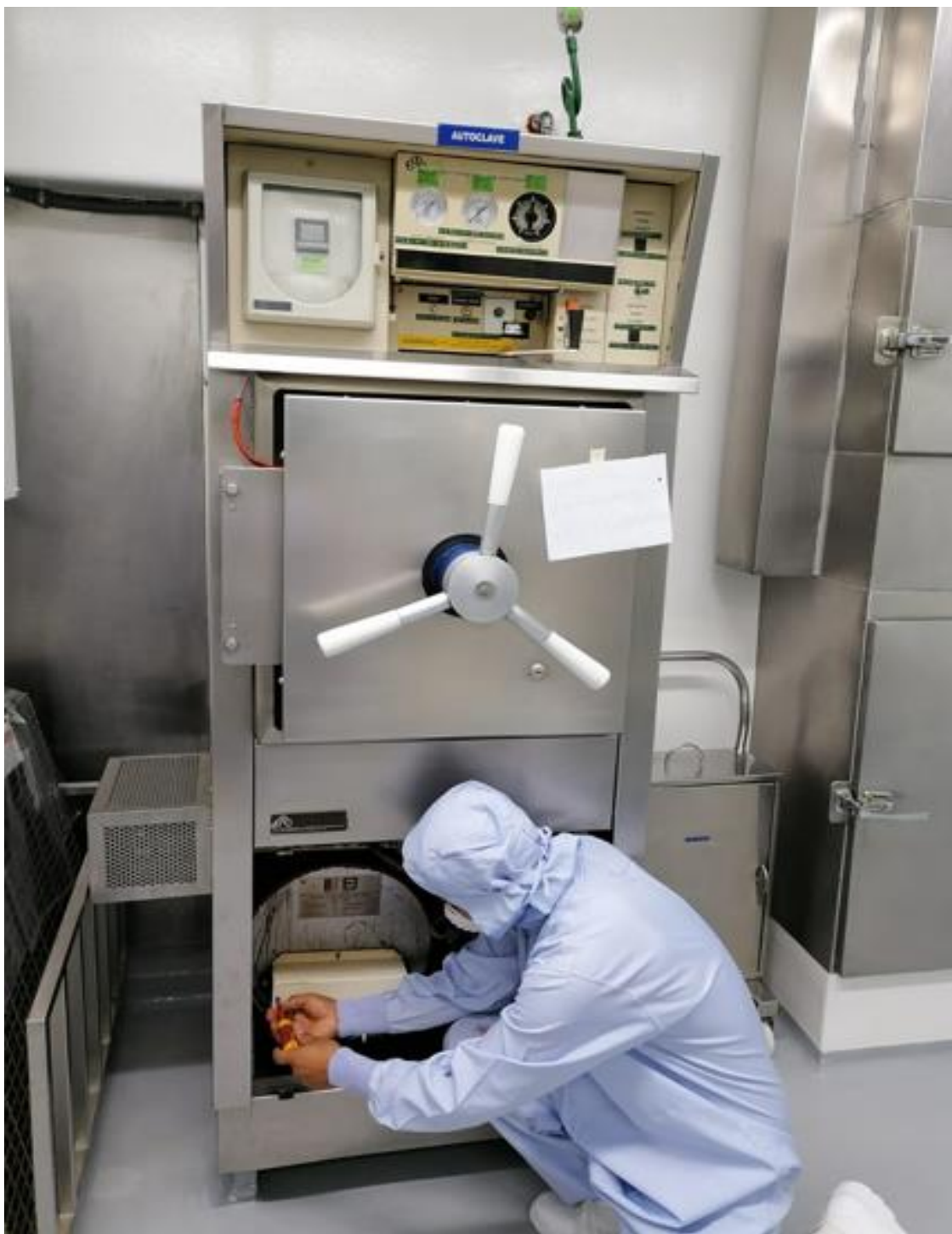
Figura 32. Técnico realizando el mantenimiento Preventivo
