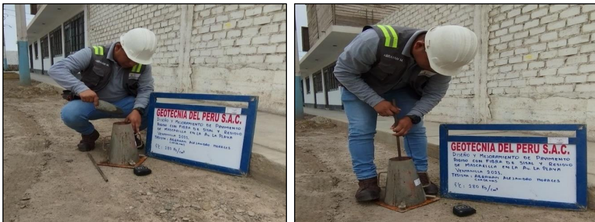
Figura 41. Ensayo del Slump del concreto
