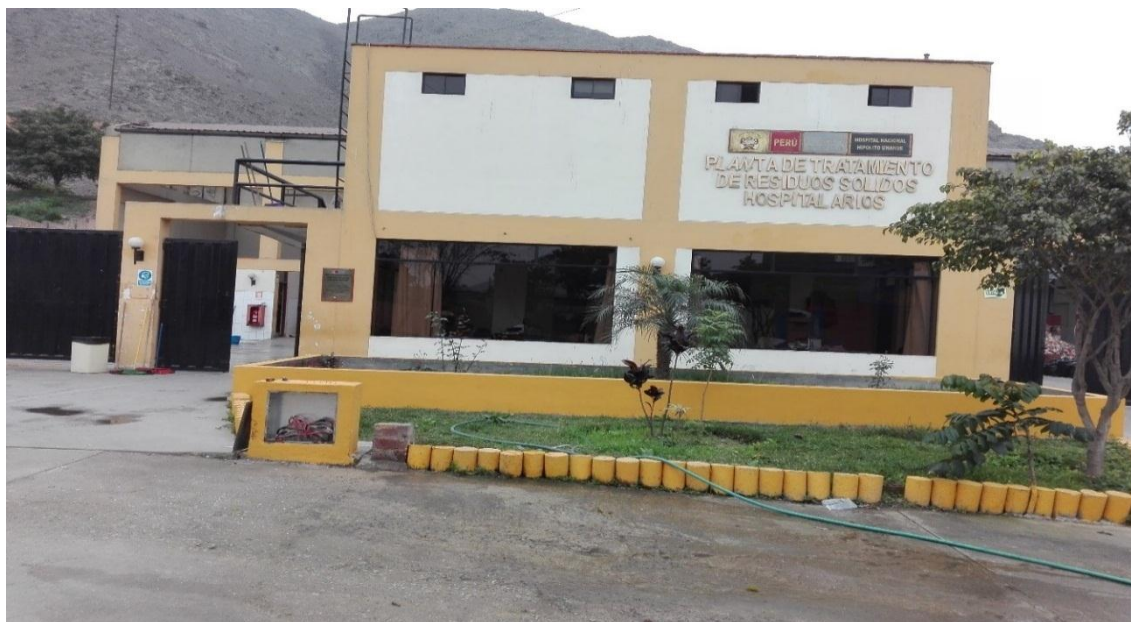
Foto 1: Infraestructura de la Planta de tratamiento de residuos sólidos hospitalarios del HNHU
