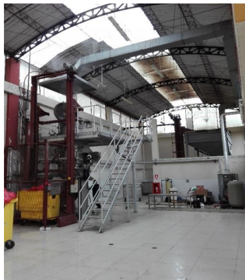
Foto 3: Sala de procesamiento de residuos biocontaminados.
