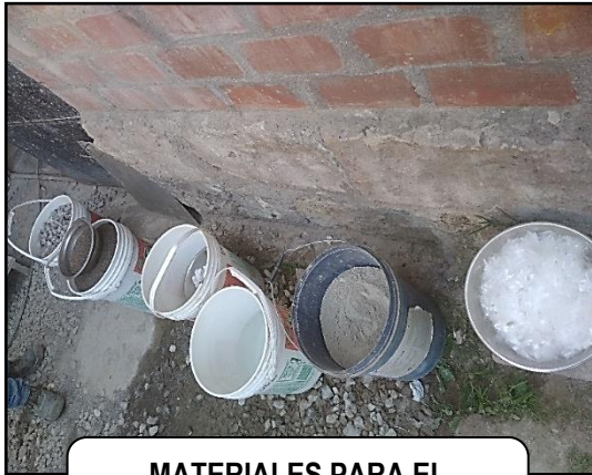
MATERIALES PARA EL VACIADO
