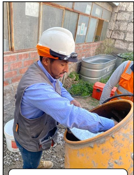
PROCESO DE VACIADO DE FIBRA POLIPROPILENO
