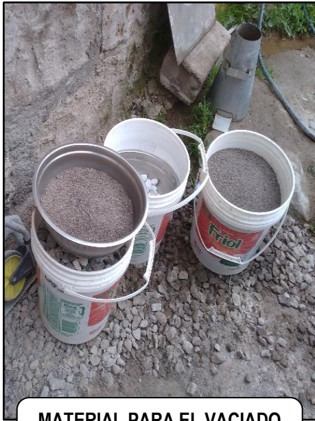
MATERIAL PARA EL VACIADO DE CONCRETO
