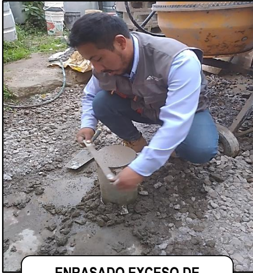
ENRASADO EXCESO DE MEZCLA CON PLACA
