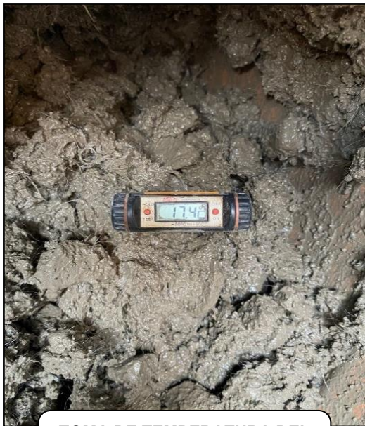
TOMA DE TEMPERATURA DEL CONCRETO = 17.4°C
