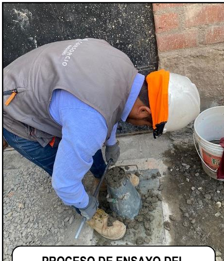
PROCESO DE ENSAYO DEL ASENTAMIENTO DEL CONCRETO
