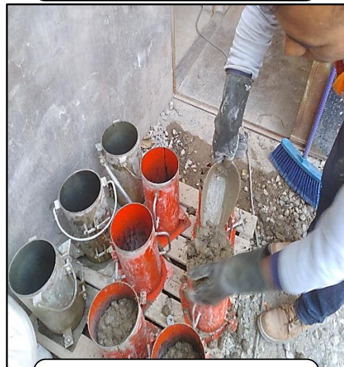
LLENADO DE CONCRETO EN PROBETAS EN 3 CAPAS
