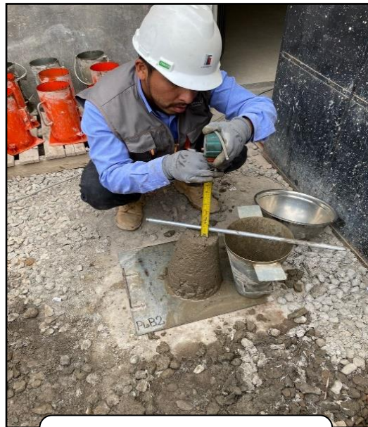
MEDICIÓN DE SLUMP DEL CONCRETO
