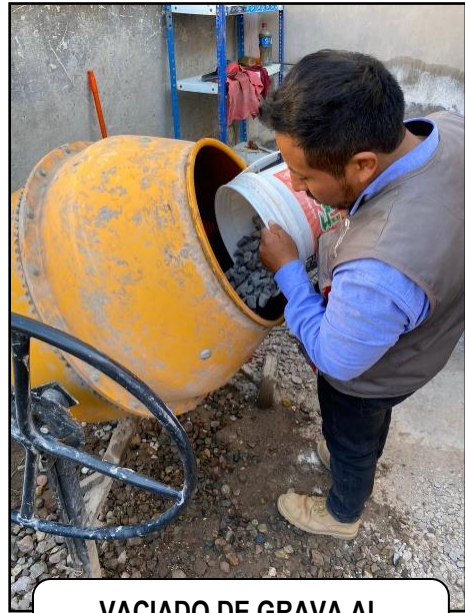
VACIADO DE GRAVA AL TROMPO
