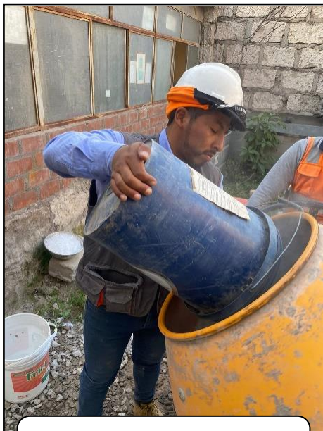
PROCESO DE VACIADO DE CEMENTO
