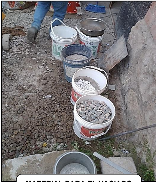
MATERIAL PARA EL VACIADO DE CONCRETO
