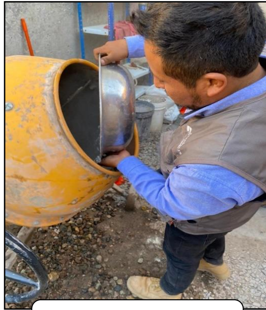
VACIADO DE CEMENTO AL TROMPO
