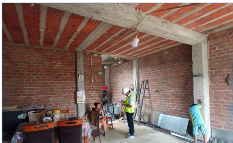
Fotografía # 03. Se determinó la densidad de muros de cada una de las viviendas focalizadas.
