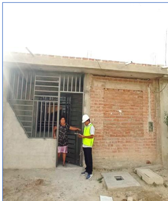
Fotografía # 02. En la evaluación sobre nivel de vulnerabilidad sísmica en viviendas de albañilería confinada, se consideró el método de Benedetti-Petrini.
