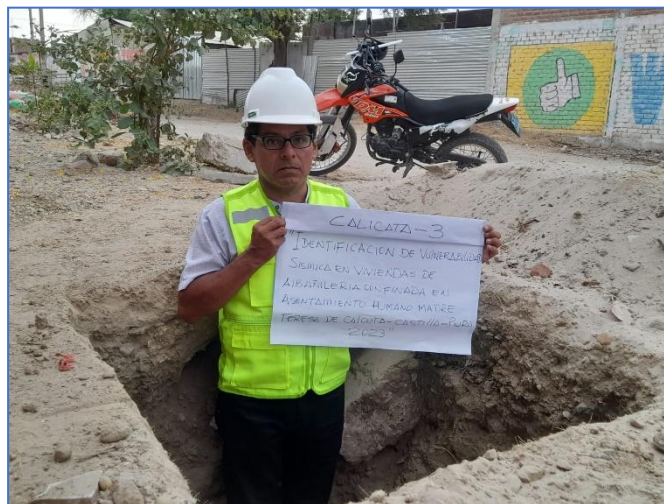
Fotografía # 06. Se realizaron 4 calicatas, para la obtención correspondiente de las muestras de suelo, las mismas que luego del análisis indicaron que en adelante las edificaciones debieran considerar la Norma E.070 y E.060.
