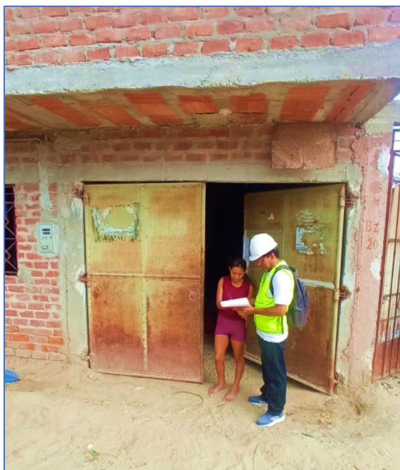
Fotografía # 01. Las viviendas seleccionadas, debían cumplir el requisito de ser viviendas de albañilería confinada.
